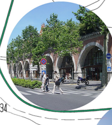
PROGETTO DI RIFUNZIONALIZZAZIONE DI UN VIADOTTO FERROVIARIO LE VIADUC DES ARTS CITTÀ DI PARIGI, FR 1988-2000 JACQUES VERGELY, PHILIPPE MATHIEUX
