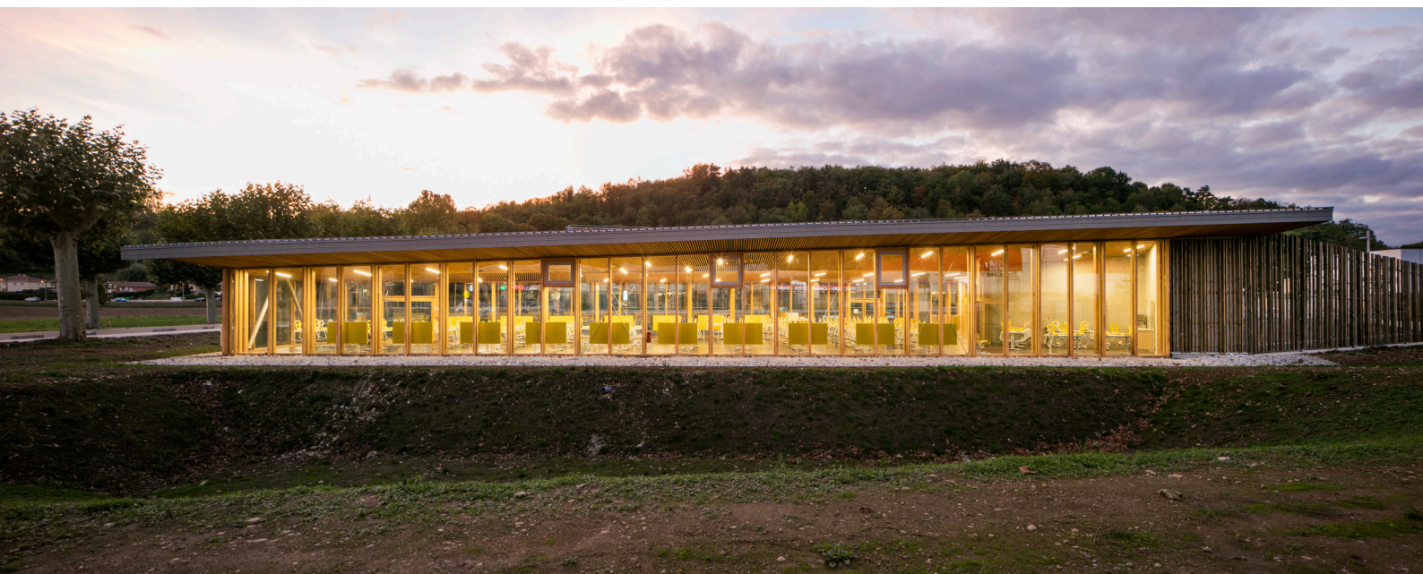
10 - La cantine présente une façade largement vitrée, ouverte sur l'espace public photo ©Édouard Decam
