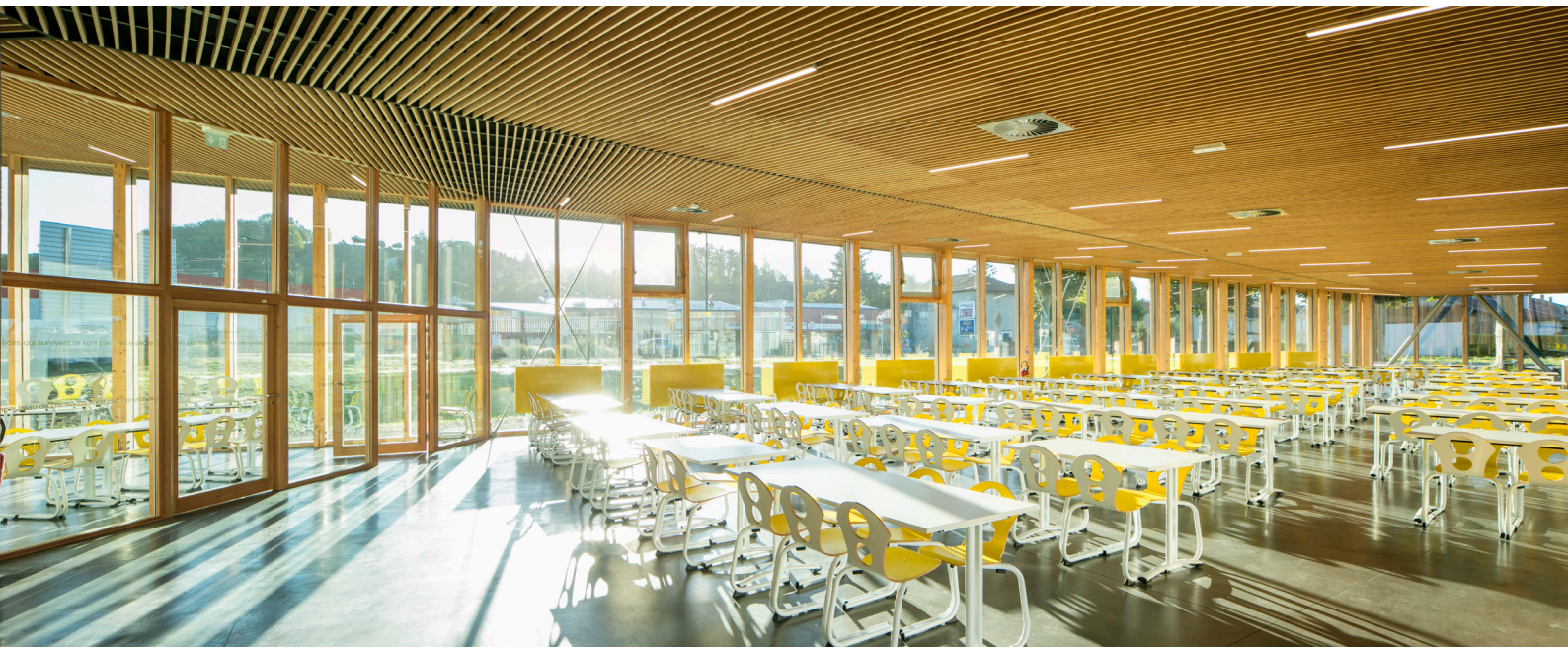
11 - Le plafond acoustique en bois et les larges baies vitrées apportent lumière et confort acoustique photo ©Édouard Decam
