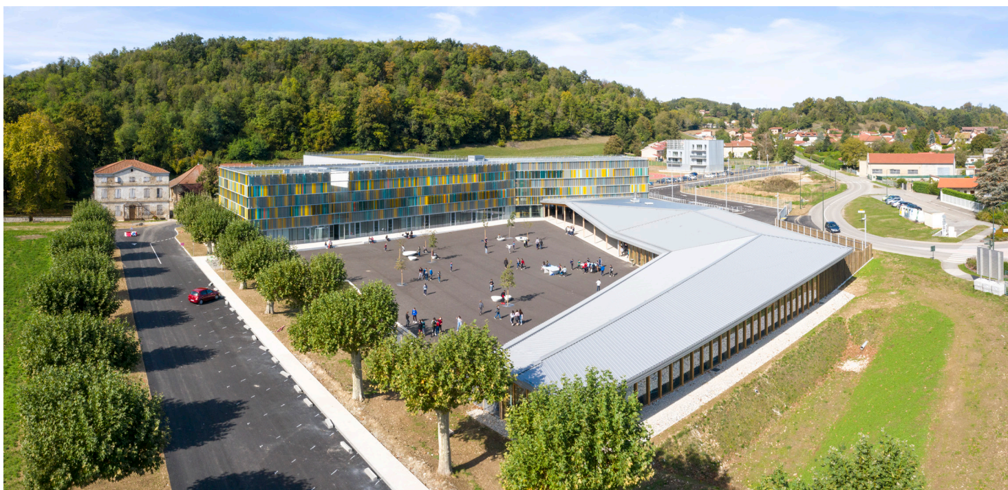
03 - La cantine referme la cour du collège et la protège des vents dominants froids photo ©Édouard Decam
