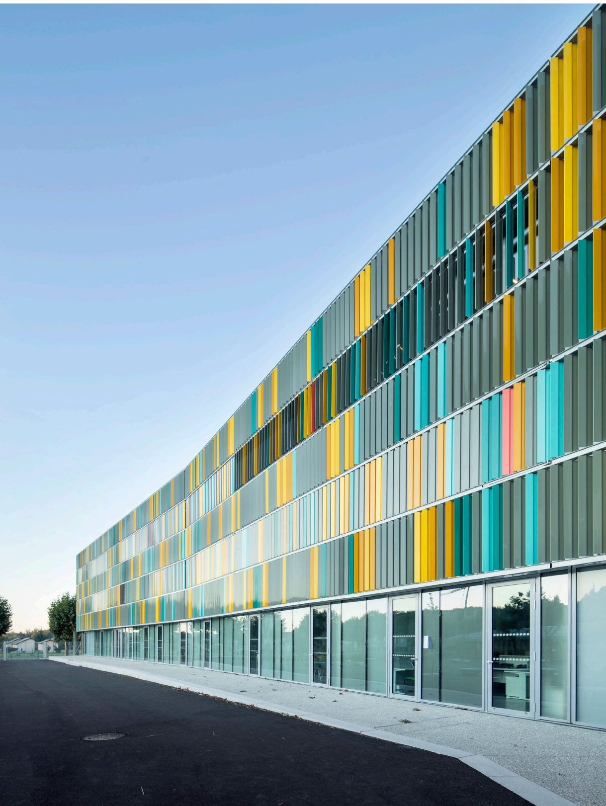
04 - La façade du collège est animée par des brises soleil verticaux photo ©Édouard Decam
