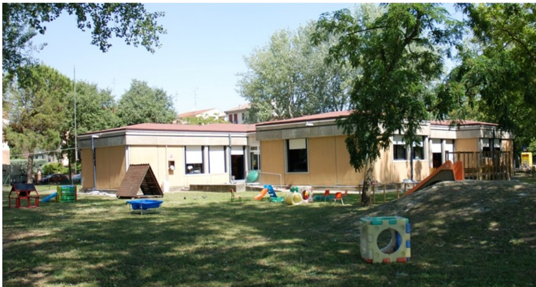
Fig. 8 – Una semplice analisi sismica avrebbe portato all'applicazione di efficaci collegamenti tra le strutture portanti prefabbricate dell'unico e ultimo asilo nido funzionante a Ferrara nel dopo terremoto. Essi sarebbero stati più che sufficienti ad evitarne la chiusura!
