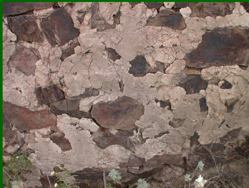
Intonaco sulla cinta muraria lato ovest
