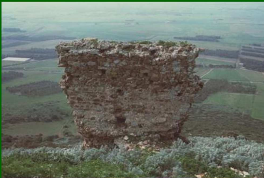
LA CORTINA MURARIA A SUD OVEST
