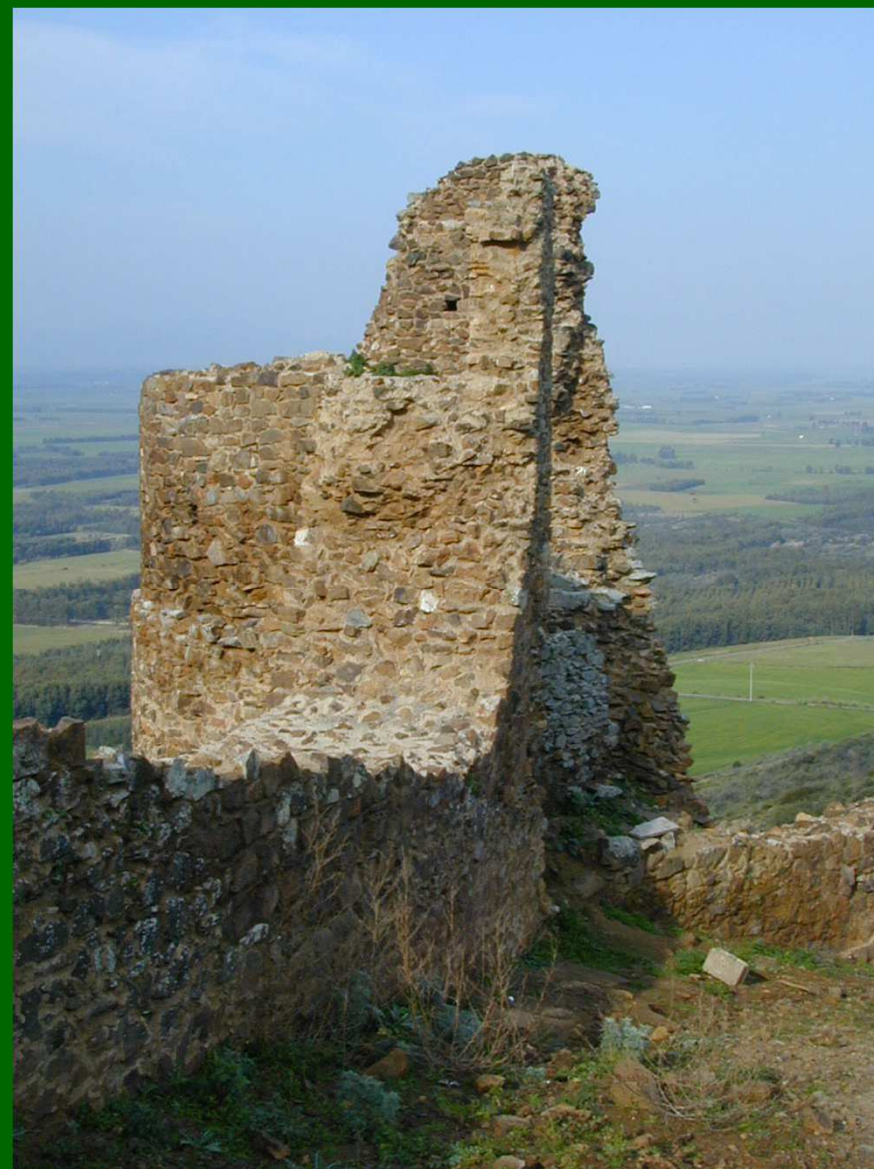
RESTAURO TORRE C E MURA LATO OVEST
