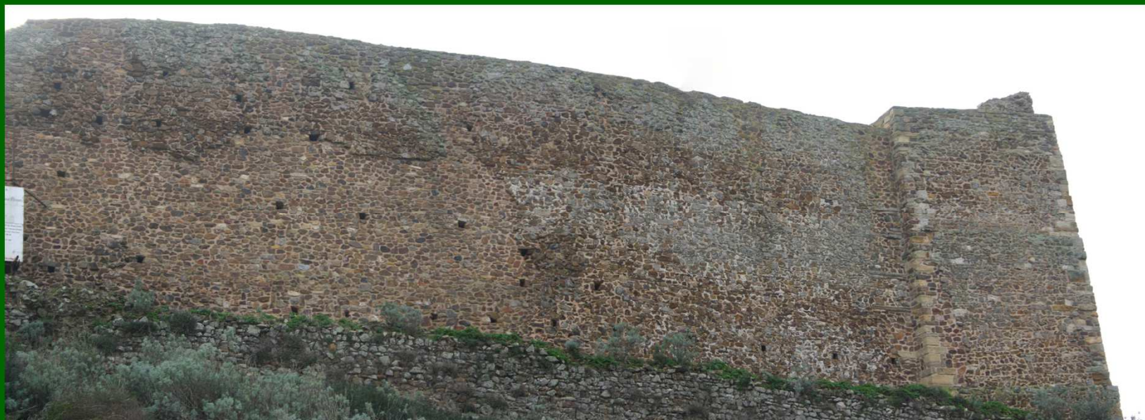
LA MURATURA ANTISTANTE IL MASTIO
