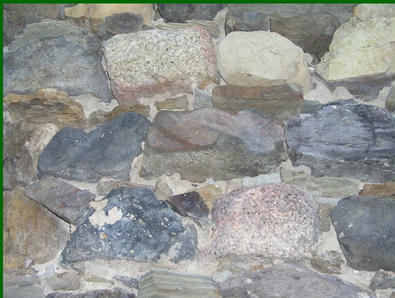
La muratura parte direttamente dai piani di stratificazione della roccia scistosa.
