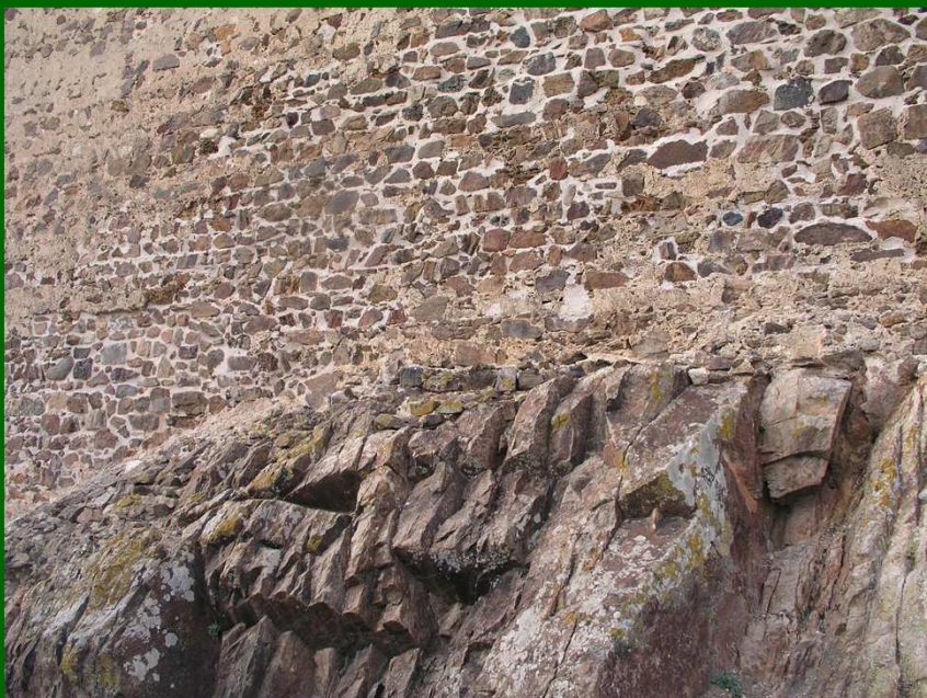
La muratura parte direttamente dai piani di stratificazione della roccia scistosa.
