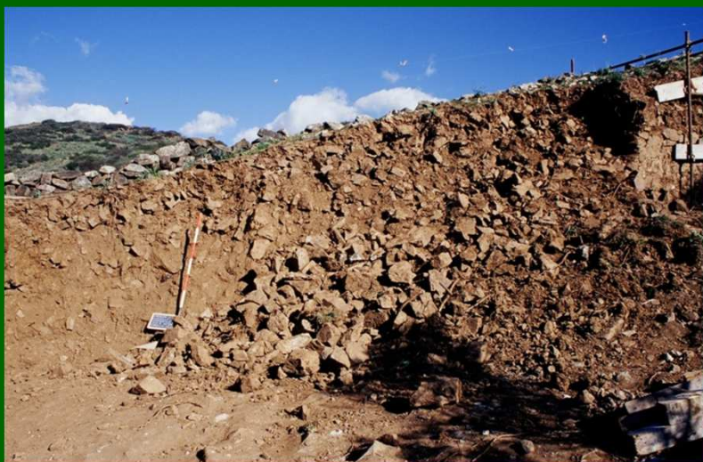
La muratura a sacco delle mura lato ovest
