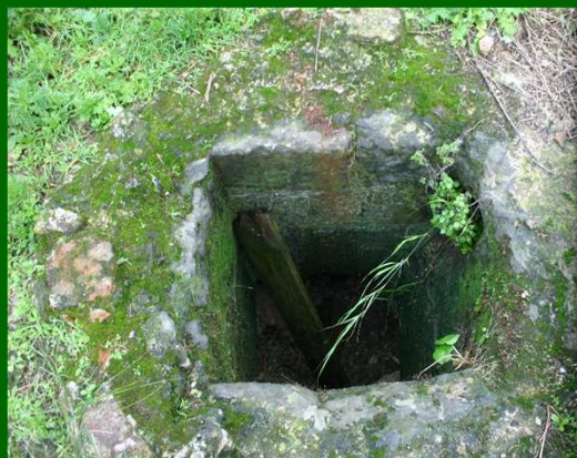
Ingresso della cisterna
