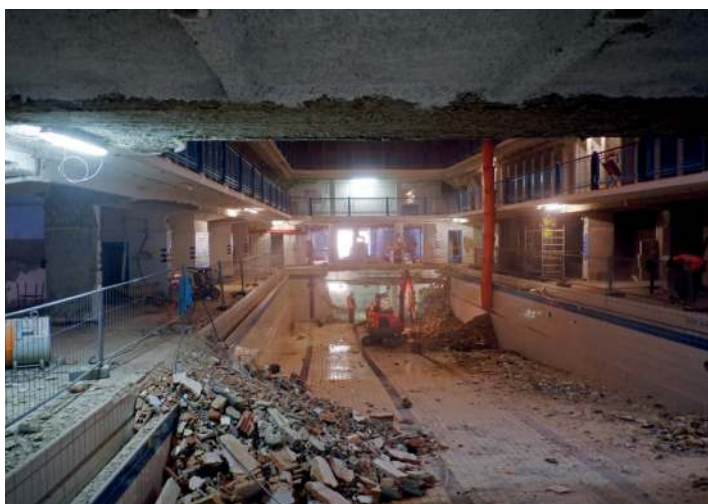
Photo du chantier de démolition du bassin
