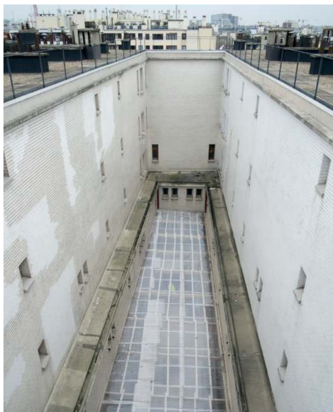
Image de la verrière restituée en cours de réalisation, 2016
