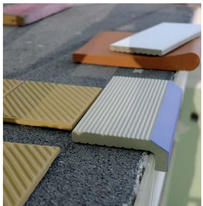
Test échantillons plage du bassin, 2017
