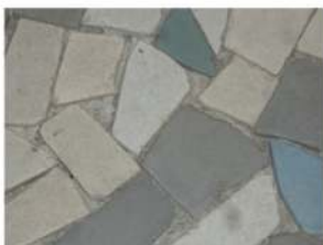
Carrelage du sol des sanitaires
