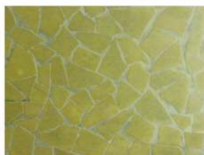
Carrelage du sol des cabines en mosaïque de hasard
