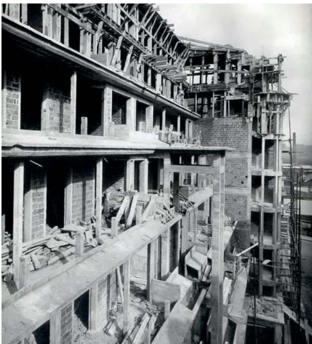
Image d'archives de la construction de l'immeuble, 1925
