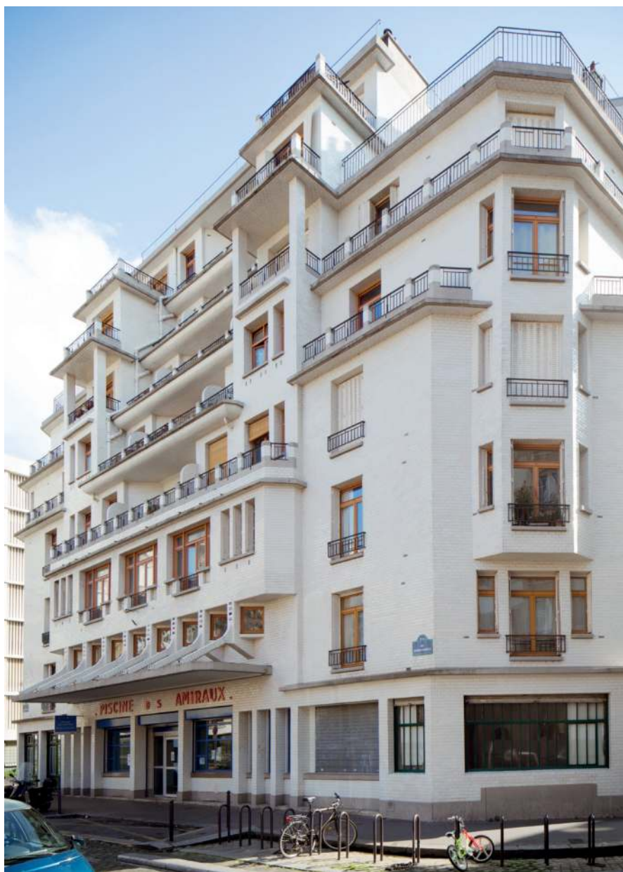
Photo avant travaux, 2014
