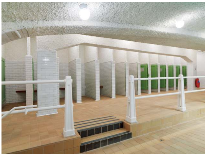
Plage du bassin après travaux, 2017
