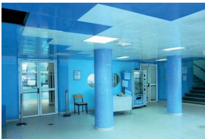
Etat existant entrée avant travaux, 2014
