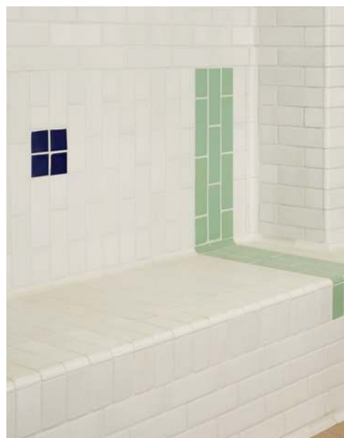
Carrelage des bancs après travaux, 2017
