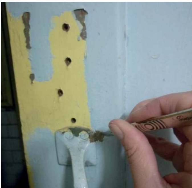
Sondage stratigraphique sur porte cabine, 2014
