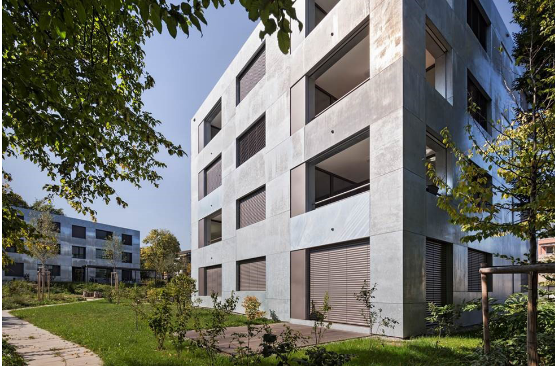
Chilestieg, Rümlang, Suisse baumschlager eberle, archphoto, inc © baumschlager eberle
