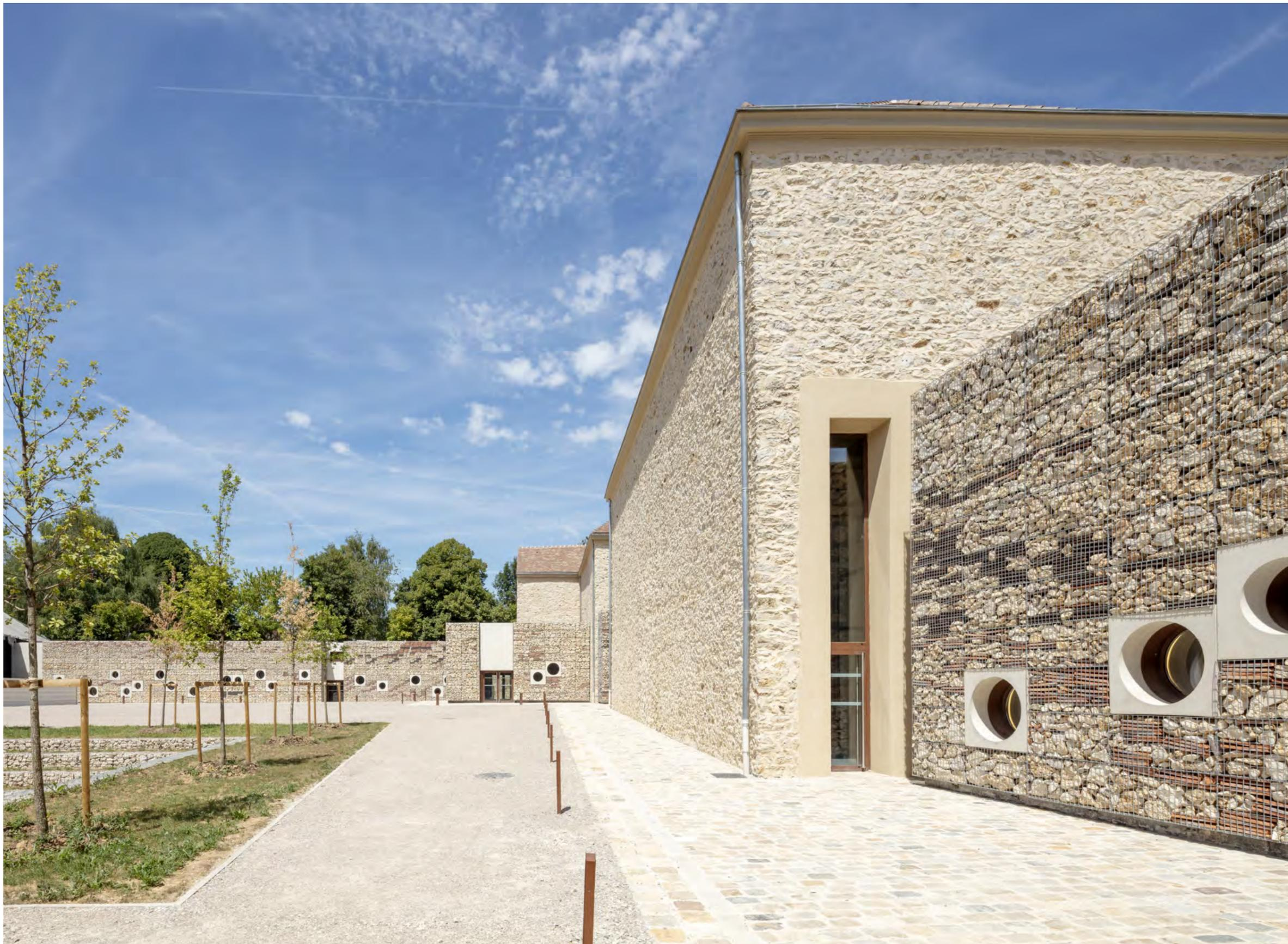
Les tuiles et les moellons ont ainsi été déposés, décrottés, criblés et stockés en différents monticules de nature et de granulométrie diverses pour ensuite être réemployés sous forme de nouvelle composition de calcaire et de terre cuite évoquant des couches géologiques et rappelant l'ancrage au territoire.
