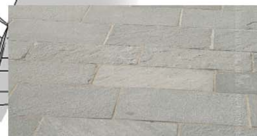
Pavimento in lastre a correre
