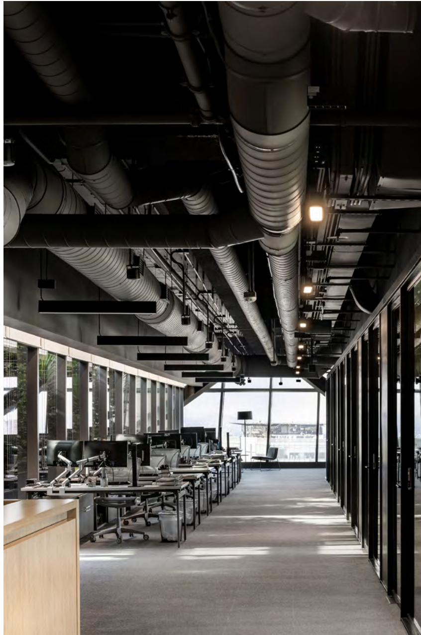
Estación de trabajo abierta
