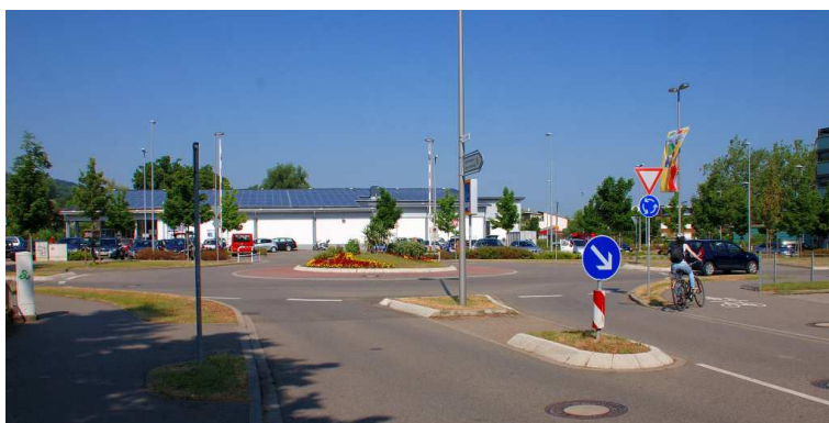
FRIBURGO (GE) Attraversamento ciclopedonale con aiuola salvagente, presso una rotatoria. La precedenza è dei veicoli motorizzati!
