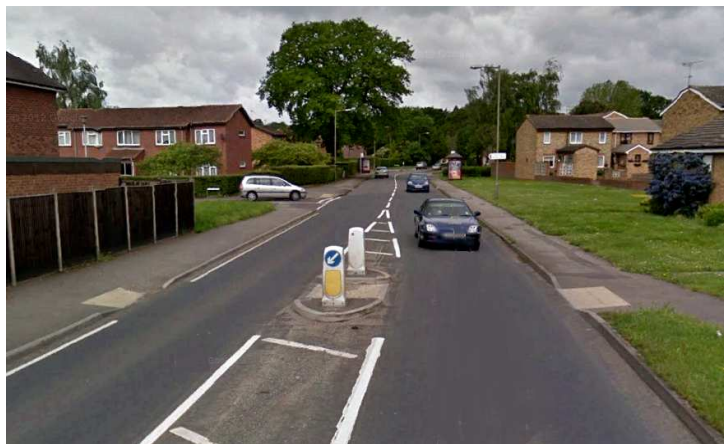
LONDRA (UK) Attraversamento pedonale su strada a due corsie con aiuola salvagente centrale e piazzole di attesa evidenziate sui marciapiedi. La precedenza è dei veicoli motorizzati!
