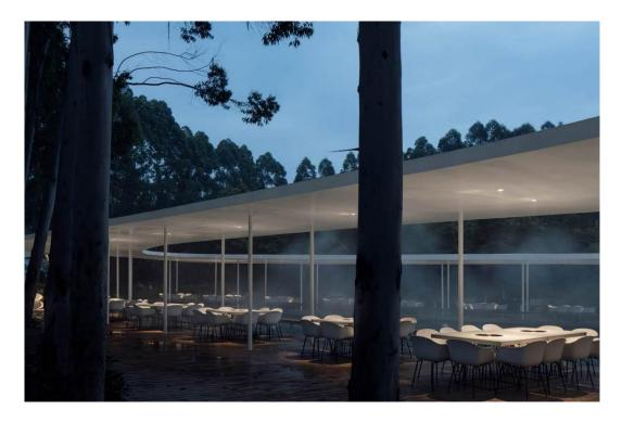
建筑总长 290 米,净高 3 米,宽度随周边的自然环境而变化。底部平台地板采用防腐木,顶部屋顶为镀锌钢板,表面喷涂白色氟碳漆,干净纯粹,与周围葱郁的环境相辅相成。建筑以直径 88mm 的钢柱作为支撑结构,远远望去,与周围笔直的桉树树干融为一体,消隐于自然中。临湖侧筑起木栏,供游览者驻足停赏。湖中睡莲沉浮,涟漪微动,低矮的栏杆模糊了建筑空间与湖水的边界,让人与自然变得更为亲近。
