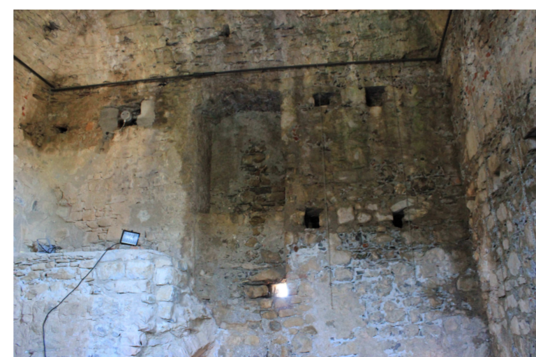
I paramenti murari, soprattutto la parte basamentale del prospetto nord presenta una forte presenza di patina biologica
