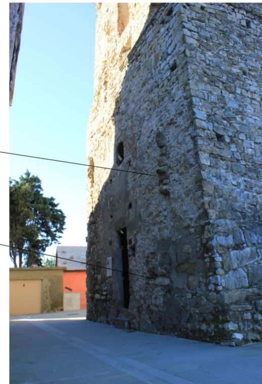
Muratura la cui pezzatura degli elementi lapidei ne permette la definizione di muratura "ciclopica"
