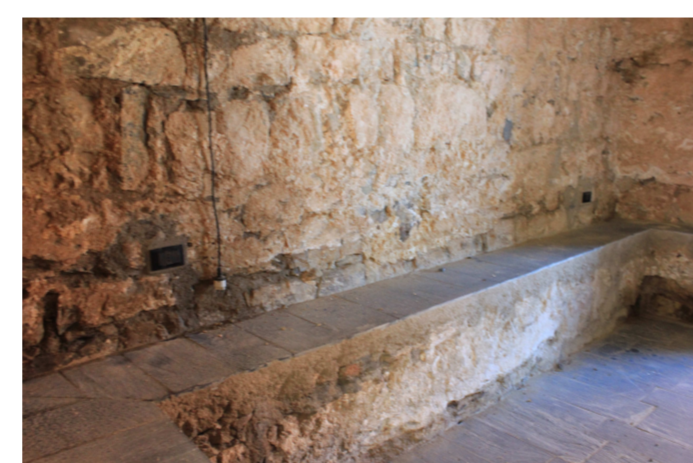
Beccatelli in laterizio presumibilmente costruiti durante la dominazione genovese, sul fronte Nord è possibile vedere anche lo stemma genovese
