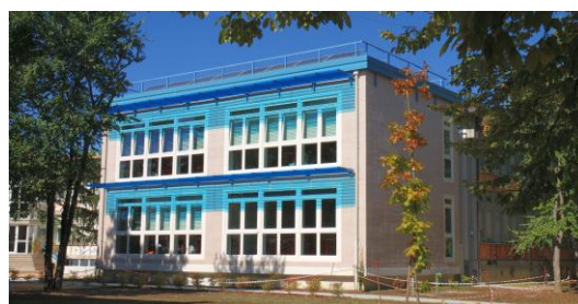
La foto dei lavori ultimati
