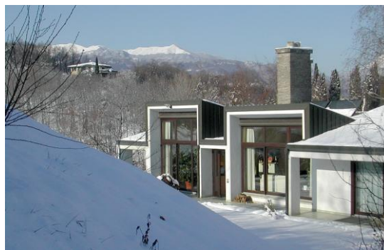
Casa solare a Onigo di Piave (TV). Un buon dimensionamento delle superfici vetrate, degli isolamenti termici, delle masse di accumulo e delle schermature consente al sole diretto di fornire il 30% del calore per riscaldamento. Costruzione 1985
