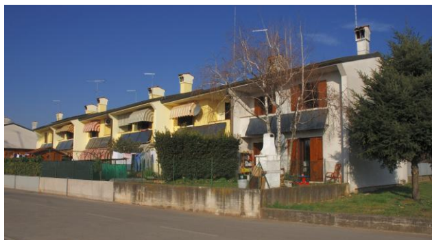
Case a schiera a Covolo di Piave (TV). Il corretto orientamento delle stanze principali e delle finestrate a Sud, ed una buona coibentazione consentono un discreto sfruttamento dell’energia solare diretta. Costruzione 1985
