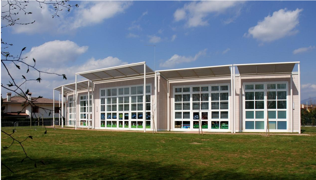
Fig. 1. Nella nuova scuola materna di Contea a Montebelluna, la presenza di grandi superfici finestrate orientate a Sud lascia penetrare molta luce solare.
