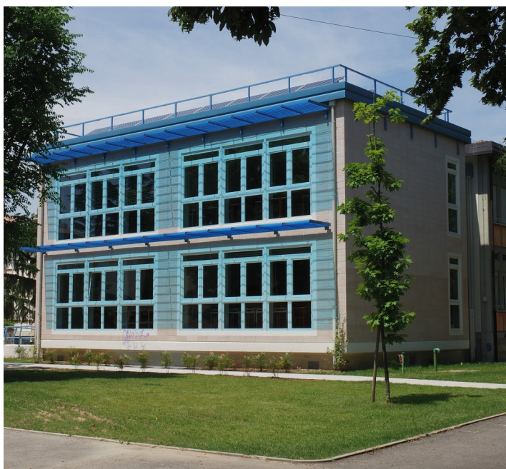
02 Scuola Media Giovanni XXIII a Montebelluna. L'utilizzo ed il controllo della luce solare diretta permette a queste quattro aule di consumare meno energia di quella prodotta dal fotovoltaico installato in copertura.
