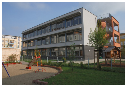
Un corretto orientamento a Sud e una corretta dimensione delle vetrate, garantiscono luce naturale ed energia solare gratuite in questa scuola a Rieselfeld (GE)
