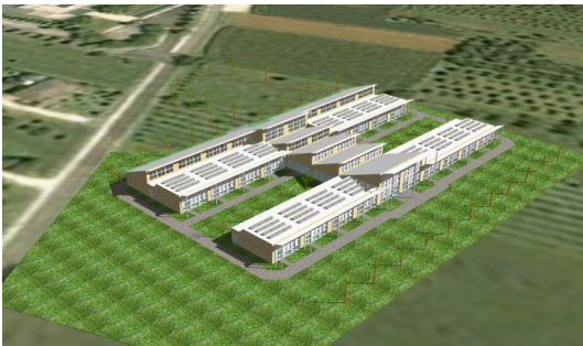
Fig. 7 - Una visione d'insieme della scuola, con esposizione a Sud delle aule ed i pannelli fotovoltaici sulla copertura
