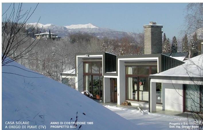
01 Casa Solare a Onigo. Realizzata nel 1983 si riscalda e viene illuminata dalla luce solare diretta.
