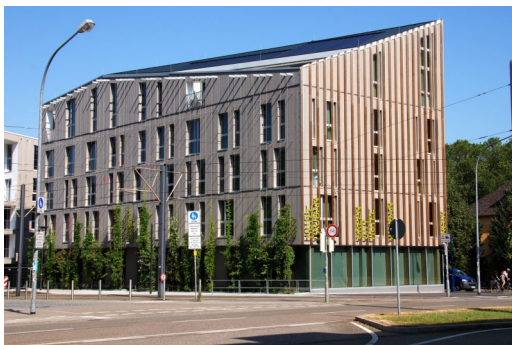
Struttura massiccia in calcestruzzo armato e rivestimento in legno completano le elevatissime qualità fisico tecniche del nuovo hotel Green City a Vauban (GE)
