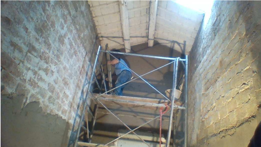
Utilizzo di ponteggio mobile per le lavorazioni in quota all'interno dell'edificio.
