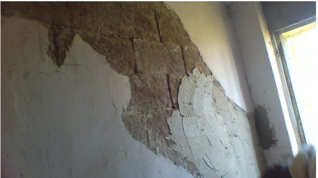
Intonaco armato applicato alla tramezza con muratura a mattoni verticali.
