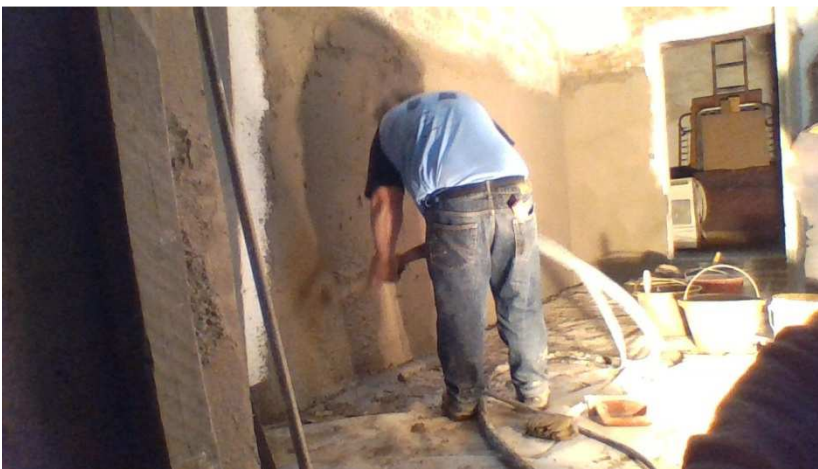
Intonaco premiscelato gettato a spruzzo, mi sono occupato personalmente di rifornire la macchina intonacatrice, posta all'esterno dell'edificio.
