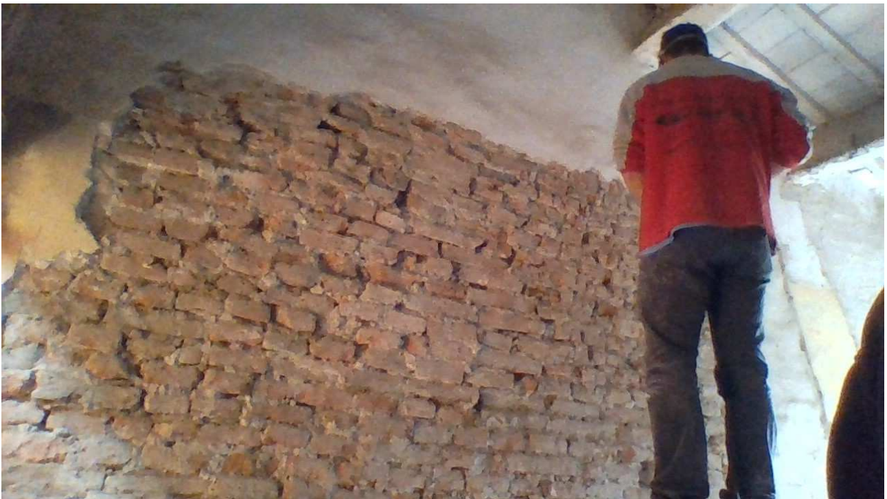
Demolizione manuale dell'intonaco da sostituire, la tessitura muraria irregolare e la qualità scadente di alcune unità hanno costituito un problema per la messa in opera dell'intonaco.
