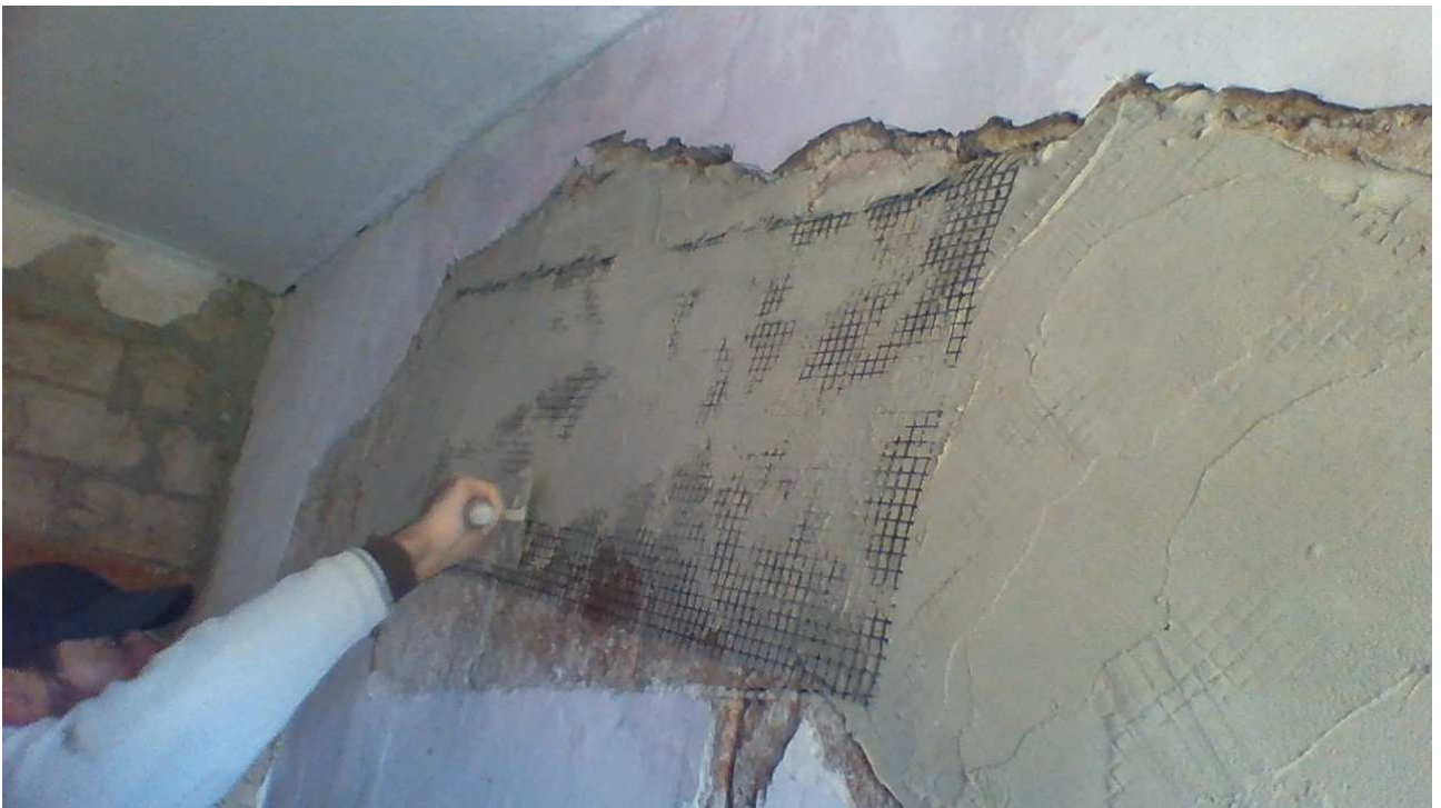
Stesura della rete in carbonio, divisa in due parti essendo molto estesa l'area interessata.
