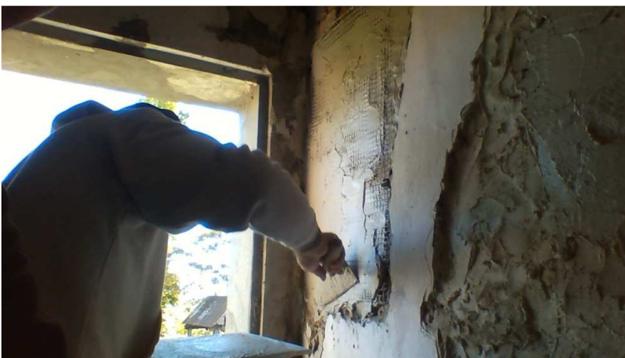
Secondo strato di calce idraulica sopra la rete.
