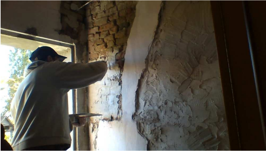
Tre fasi della posa in opera dell'intonaco armato con rete in carbonio.
