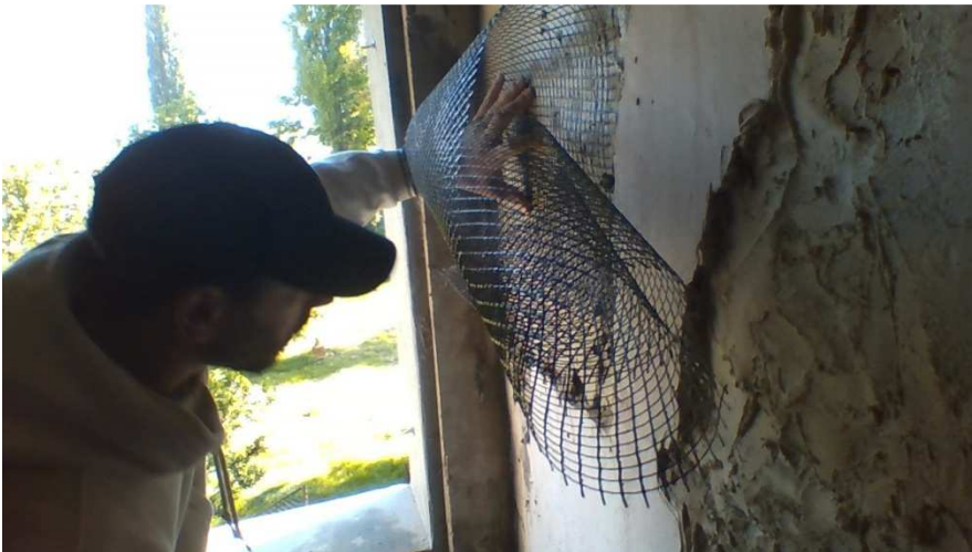
Posa in opera della rete.
