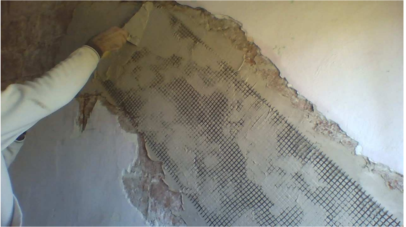
Stesura della rete in carbonio, divisa in due parti essendo molto estesa l'area interessata.
