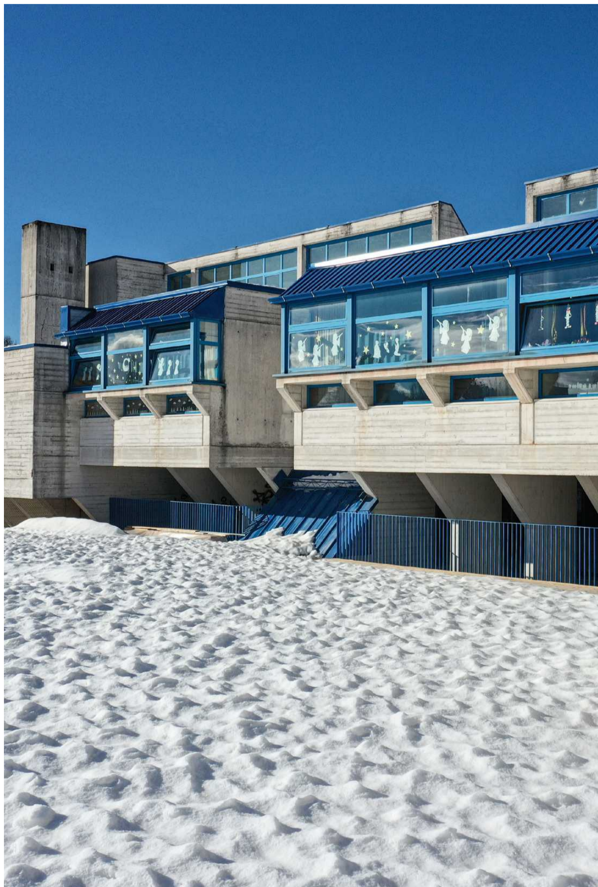
Vista sul retro delle aule. View of the back of the classrooms.
