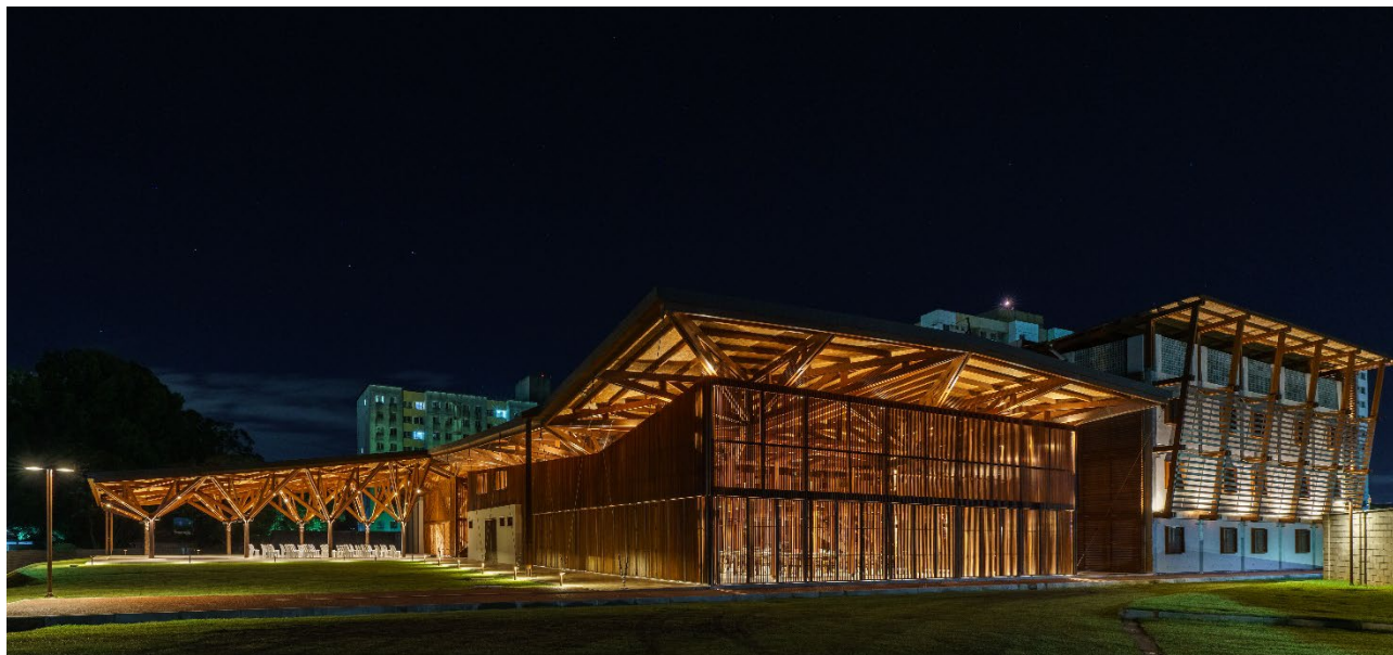
Il prospetto Ovest del refettorio. La copertura che è staccata dall'involucro edilizio per permettere all'aria calda di uscire.
