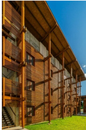
Gli alloggi visti da nord-est
