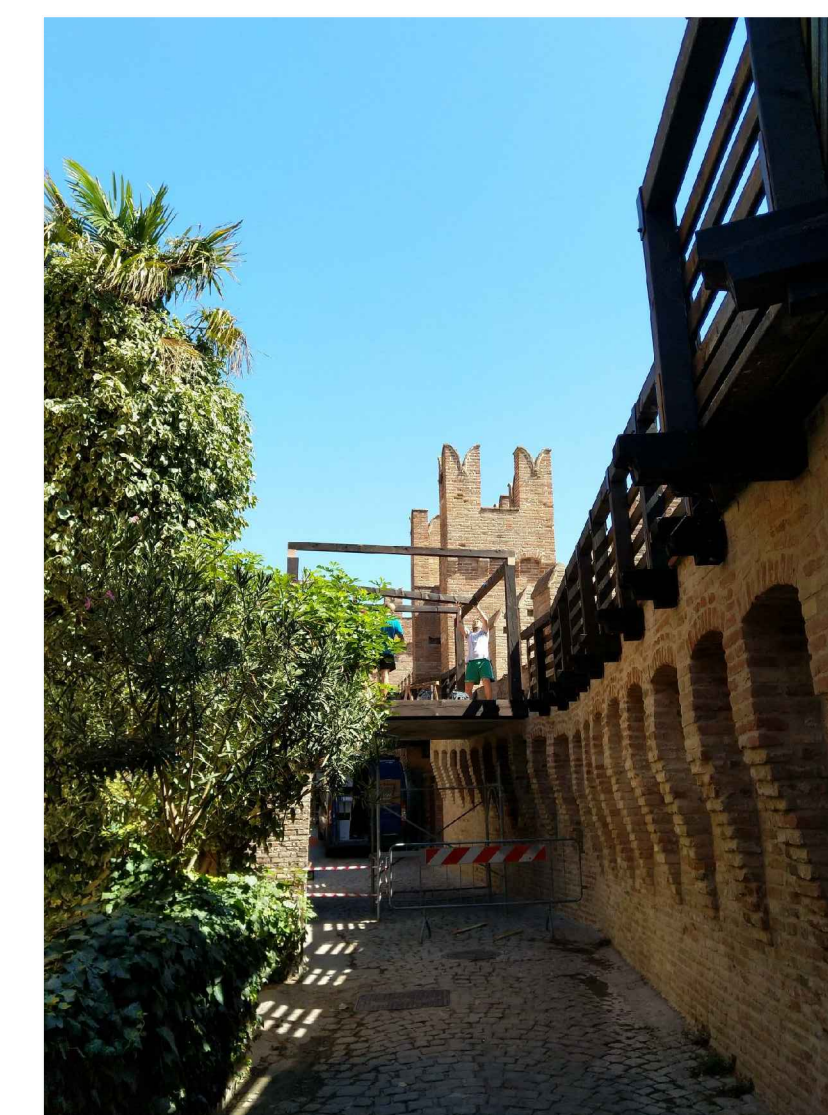
GAZEBO IN LEGNO IN FASE DI REALZZAZIONE
