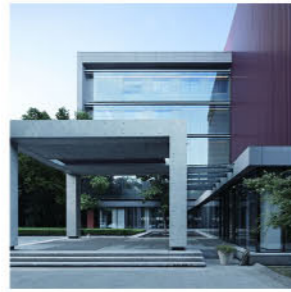
浙江大学西溪校区东一教学楼改造（绿色建筑） 2015年度教育部优秀建筑工程设计二等奖
