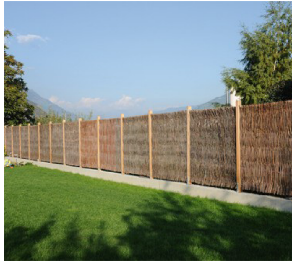
Le roseau peut être aussi tressé en panneaux épais et utilisés comme clôture.
