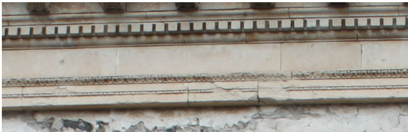
Particolare della parte inferiore del cornicione sommitale su via V. Emanuele II
