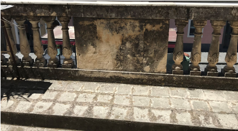
Particolare lato interno della balastra loggiato di via Vitt. Emanuele II
