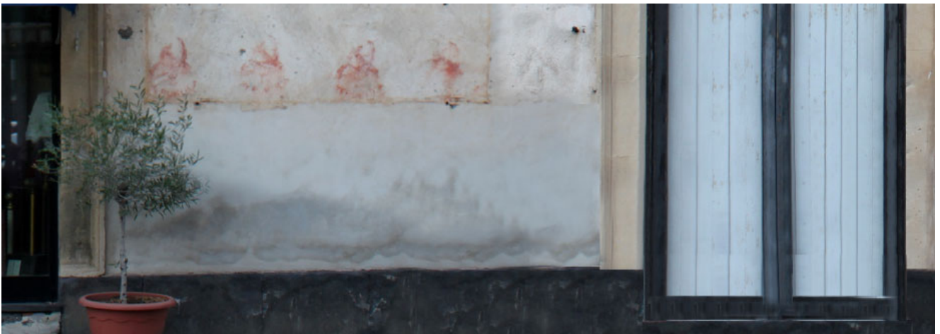
Particolare della porzione basamentale sinistra di via Difesa
