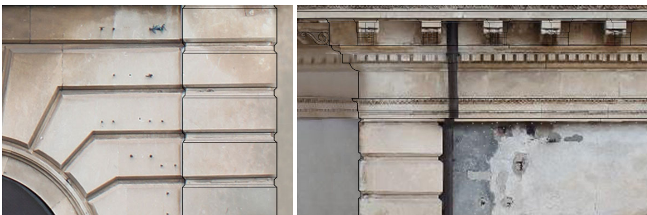
Particolare bugnato lato sinistro prospetto via Vitt. Emanuele II
