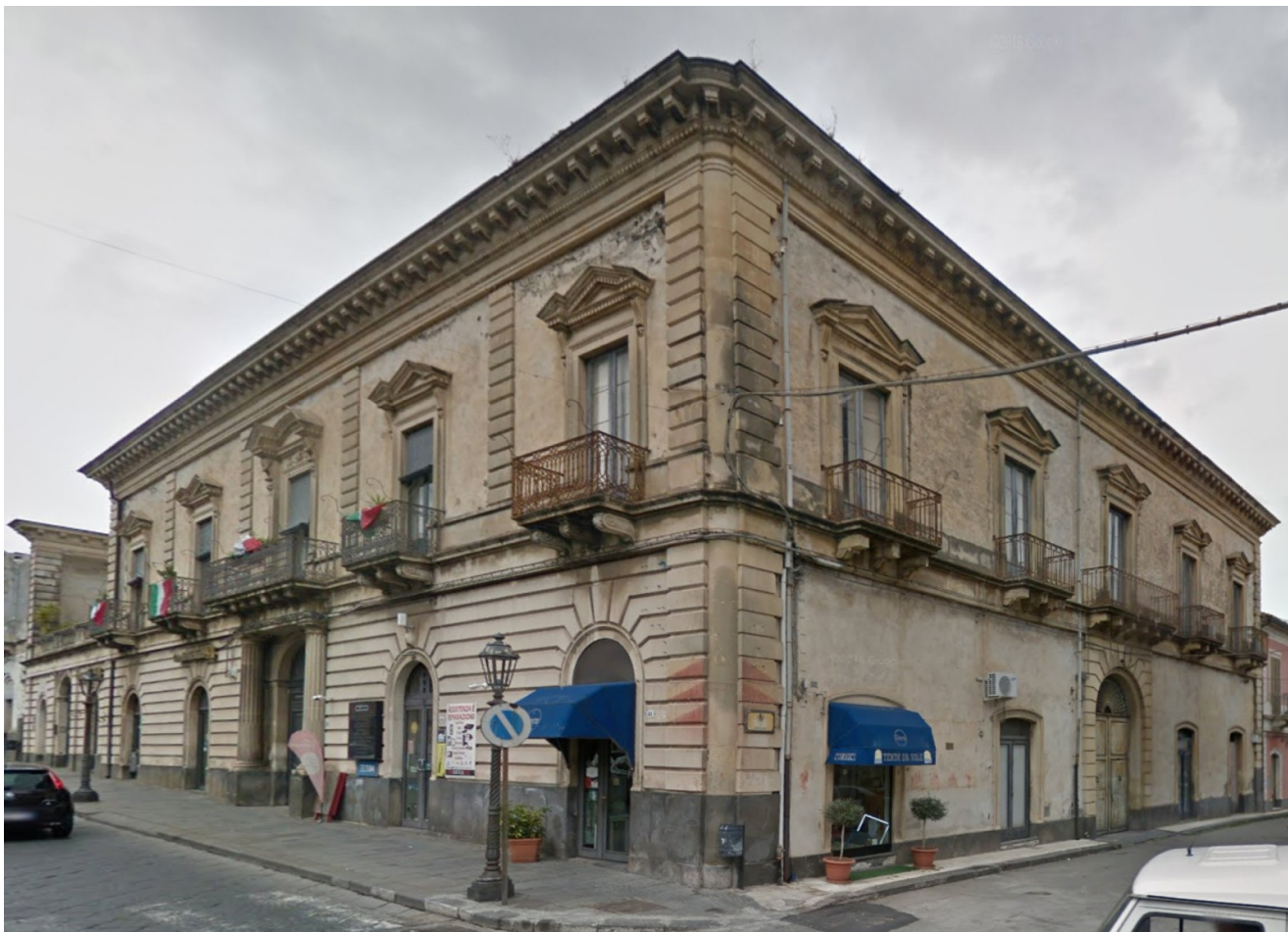
Fig.7. Veduta d'insieme di Palazzo Morabito. In primo piano la soluzione d'angolo tra corso Vittorio Emanuele II e via Difesa.
