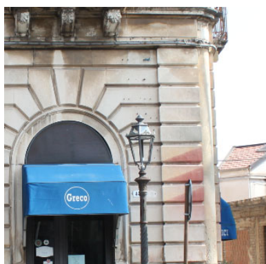
Dettaglio angolo Via V. Emanuele II
