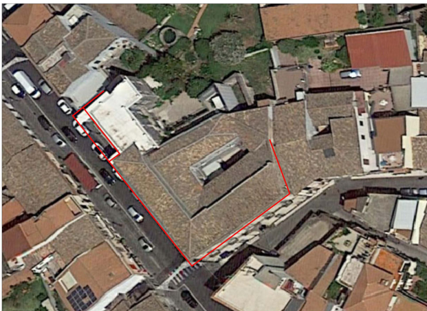
Fig.1 Foto aerea con indicazione dei fronti oggetto di intervento
