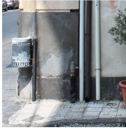
Particolare basamento d'angolo lato via Difesa
