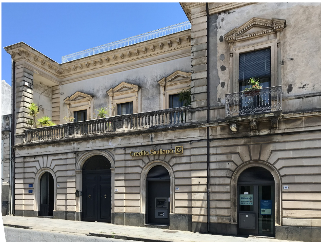
Fig.8. Palazzo Morabito. Veduta dell'ala nord realizzata nei primi anni '30, con l'cornicione arretrato che racchiude il loggiato.
