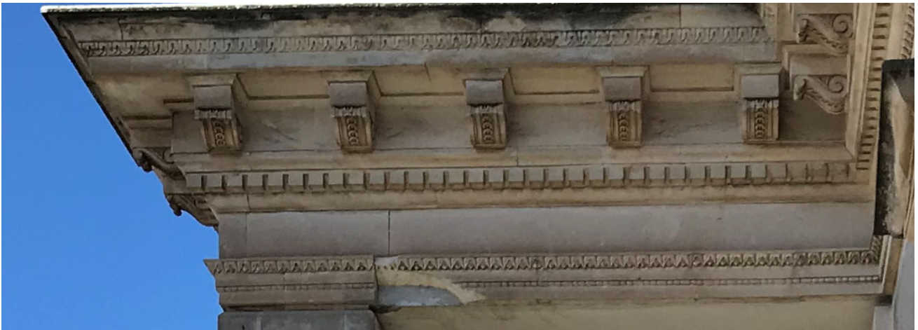
Particolare del cornicione sommitale in corrispondenza del loggiato su via V. Emanuele II
