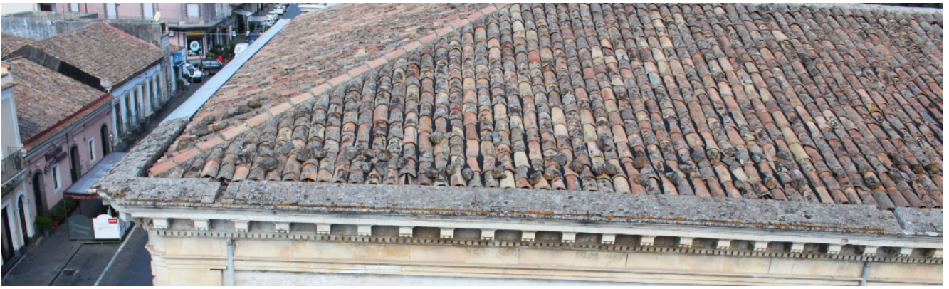
Canale di gronda via Difesa angolo via Vitt. Emanuele II
