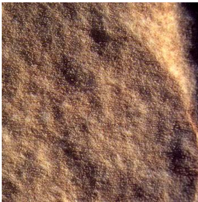
Εικόνα Β.1: Φθαρμένη επιφάνεια μαρμάρου του Παρθενώνα εξαιτίας της ατμοσφαιρικής ρύπανσης (25).
