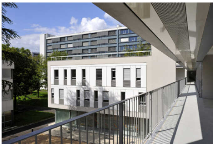
Vue depuis les passerelles du bâtiment Magellan
