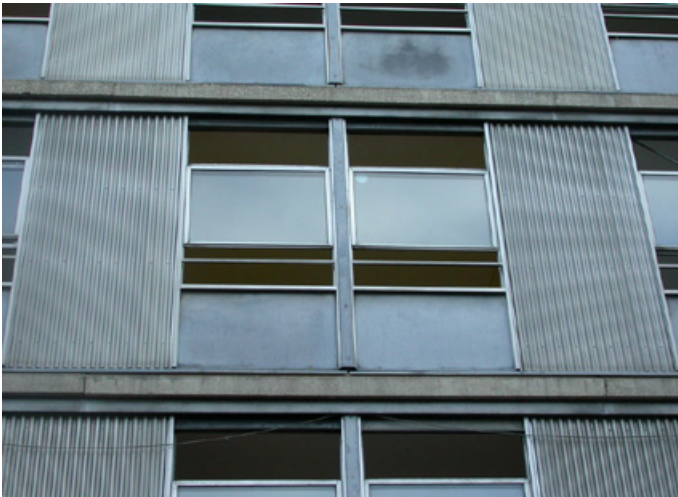
Façades industrielles de Jean Prouvé avec fenêtres à guillotine, bâtiments C et D
