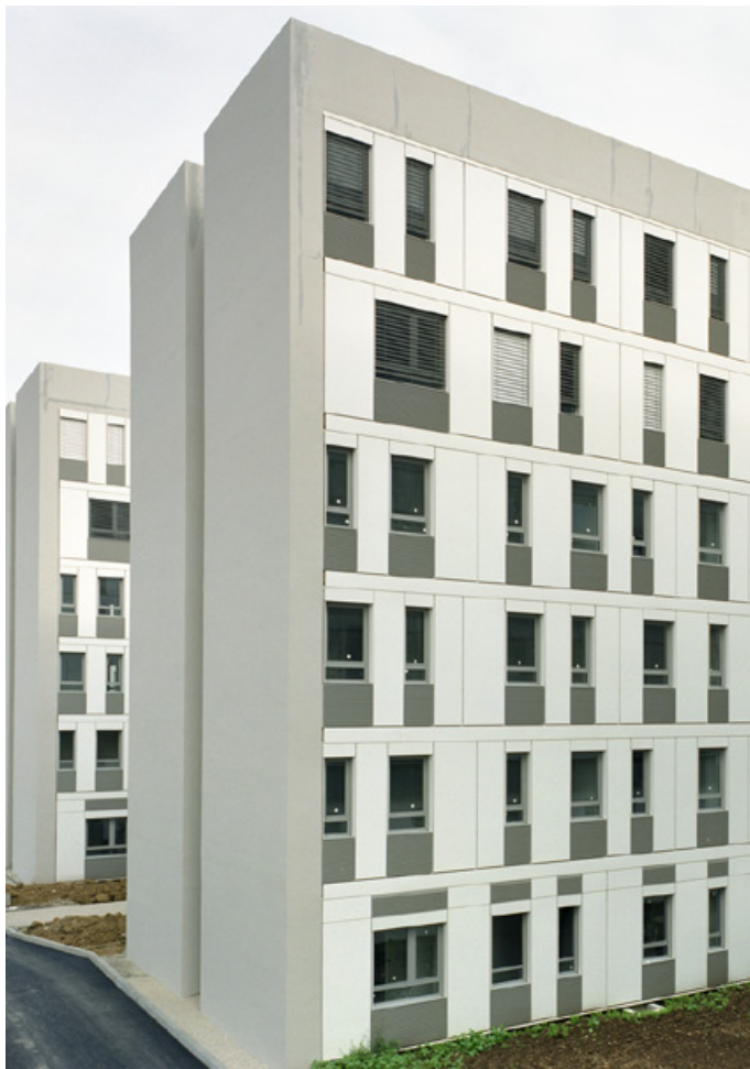
Vue arrière des bâtiments Magellan
