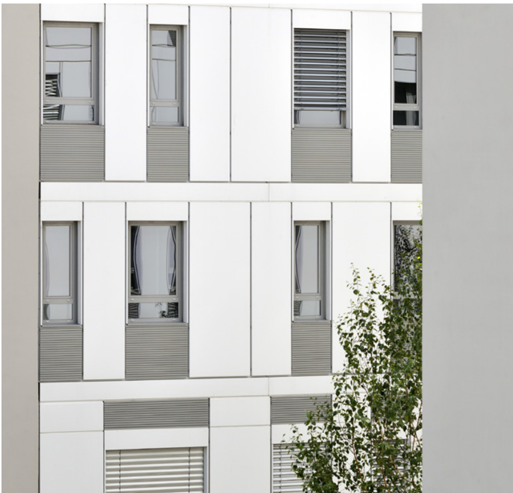
Détail des façades du bâtiment Magellan
