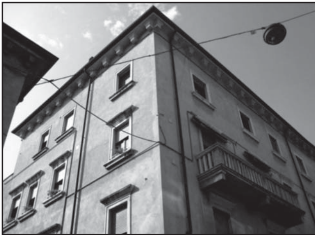
L'edificio oggetto di riqualificazione. La difficoltà di isolamento dall'esterno ha portato i progettisti ad approfondire le valutazioni energetiche e igrotermiche per ottimizzare l'intervento di isolamento dall'interno.
