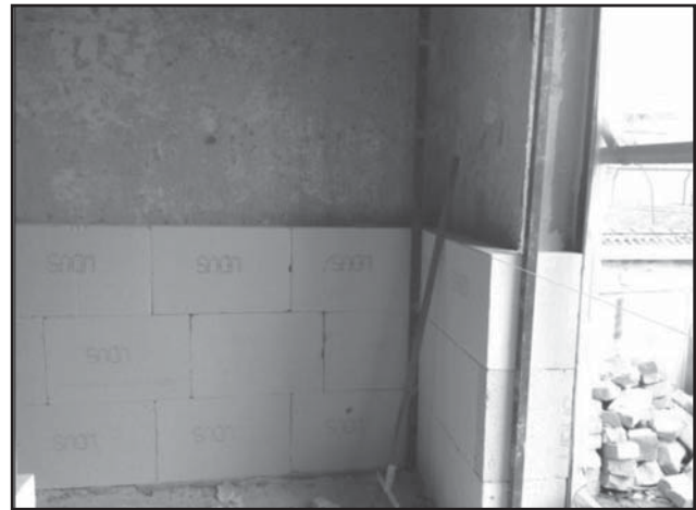
Posa in opera. Le operazioni di posa dei pannelli minerali in idrati di silicato di calcio prevedono, incollaggio dei pannelli, rasatura armata e finitura al civile.
