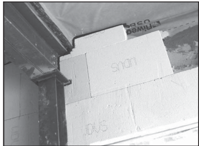
Dettagli, nastri espandenti e tenuta all'aria. Particolare cura è stata posta nella progettazione e realizzazione dei nodi architettonici connessi con i serramenti al fine di ridurre le dispersioni e garantire la tenuta all'aria dell'edificio
