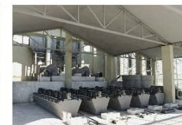
Schiumogeni - Impianto di Flottazione
