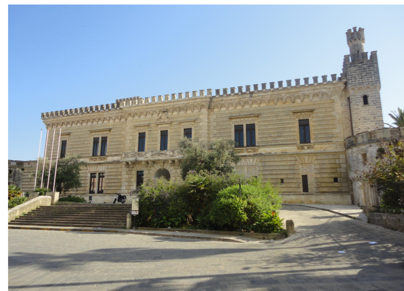
Tavole tecniche relative alla progettazione del percorso tecnologico emozionale da prevedere nei sotterranei e sulle terrazze esterne del Castello Acquaviva d'Aragona di Nardò
