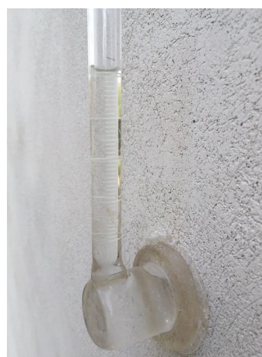
Misura col tubo di Karsten, sulla superficie trattata con idrorepellente silossanico
