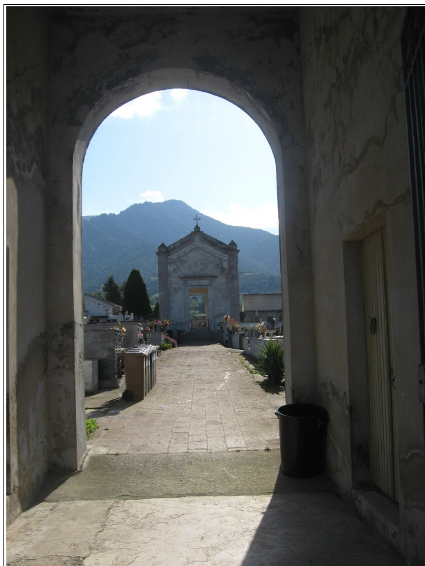
Ingresso 1° impianto: degrado
