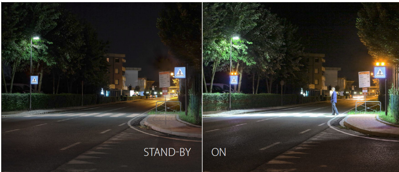
(esempio di sistema illuminazione attraversamento pedonale previsto)
