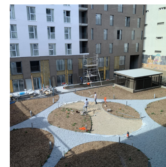
14_LE SAND (LOGEMENTS) © WAW Architectes Vue sur le coeur d'îlot en chantier
