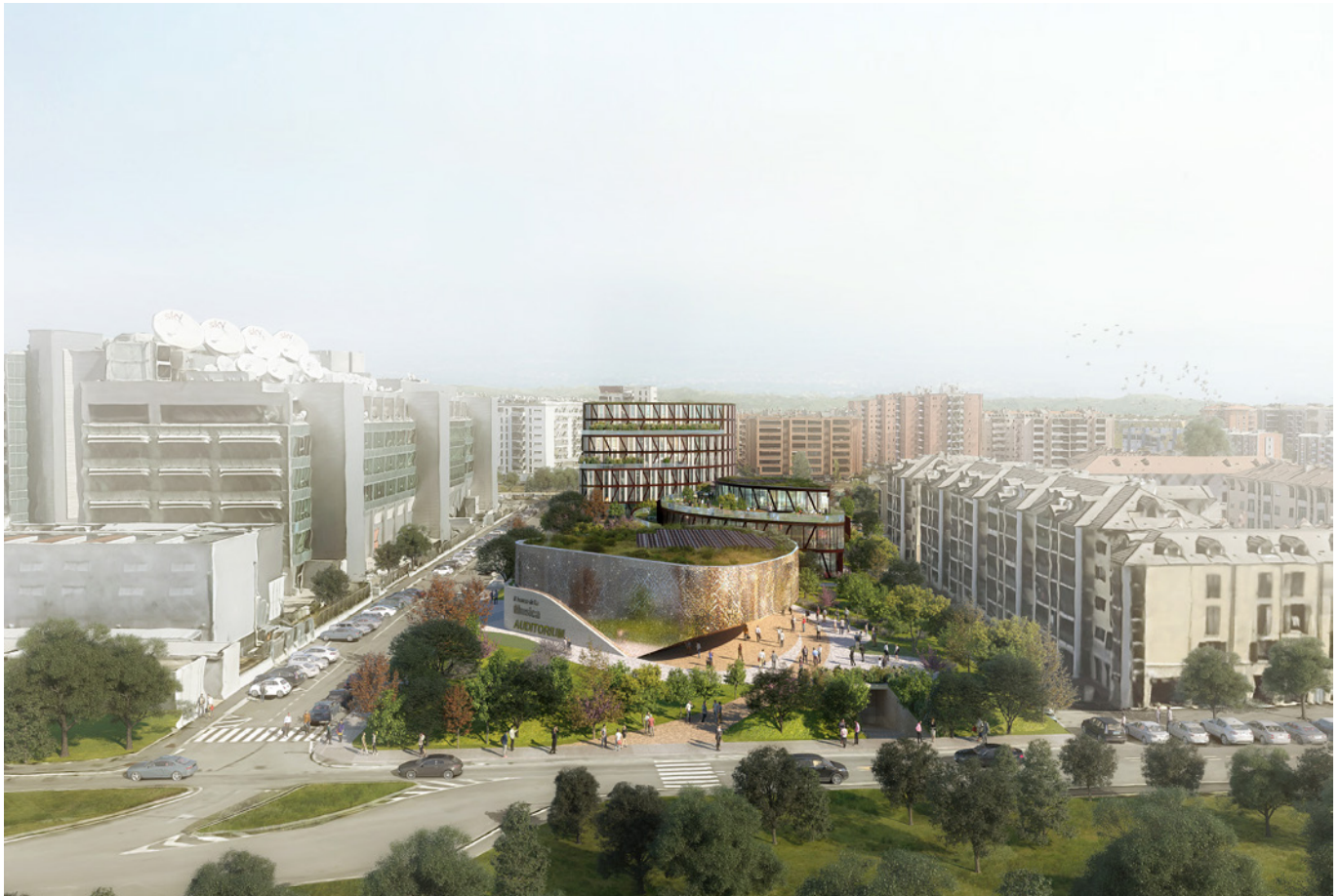
Vista aerea generale
