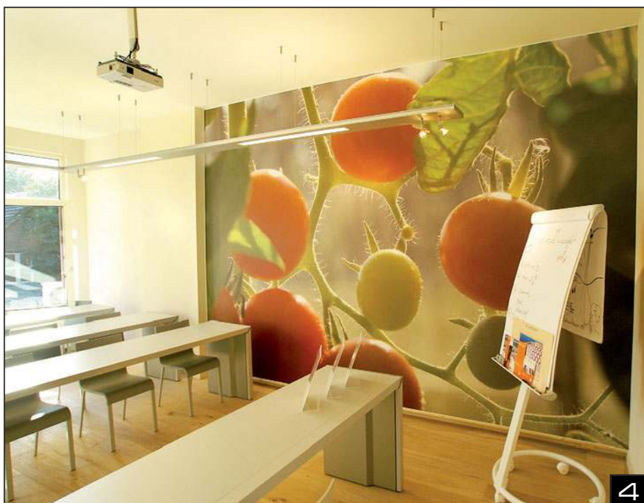
Photo 4 : Salle de formation d'une entreprise cosmétique - Pays-Bas (mur acoustique imprimé) Architecte : Doret Schulkes - Réalisation : I-OMS NL
