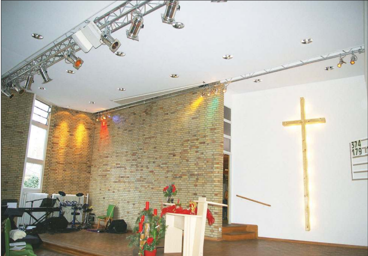
Église évangélique - Allemagne (plafond acoustique) - Photos : Andreas Heidler - Réalisation : Baumann Spanndecken
