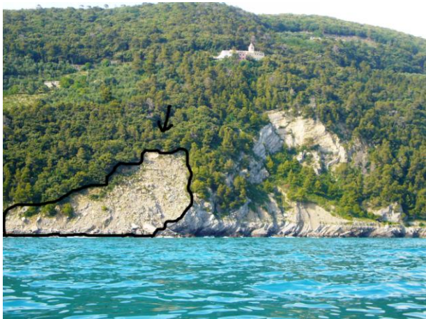
Si possono osservare le frane che interessano l'area in esame
