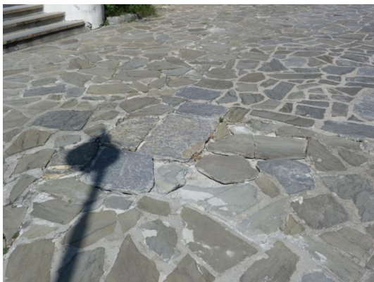
Pavimentazione 1 – fronte sud portico
