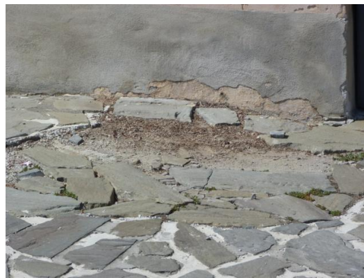
Pavimentazione 2 – fronte prospetto sud chiesa
