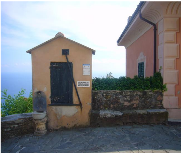
Casa e cisterna di fronte al prospetto sud della chiesa
