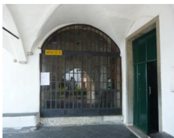
Inferriata della cappella – entrata cappella lato sud
