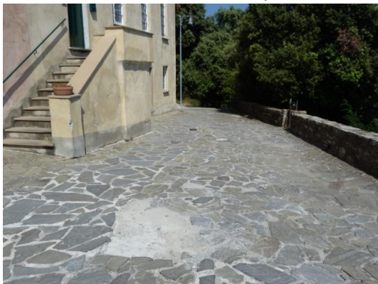
Pavimentazione 3 - fronte prospetto sud chiesa
