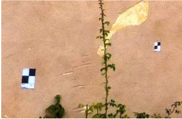
A sinistra un segnalino per raddrizzamento, a destra un segnalino di livello
