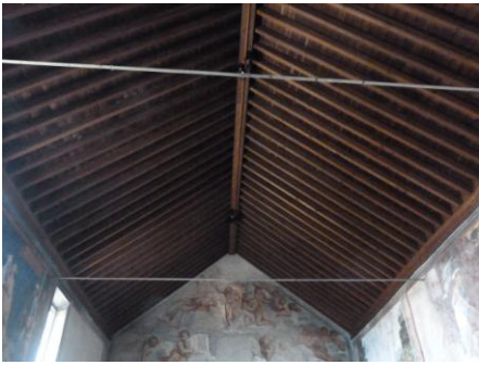
Copertura del Santuario in legno
