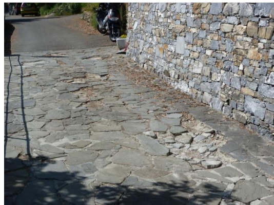
Pavimentazione 4 – strada di accesso ovest
