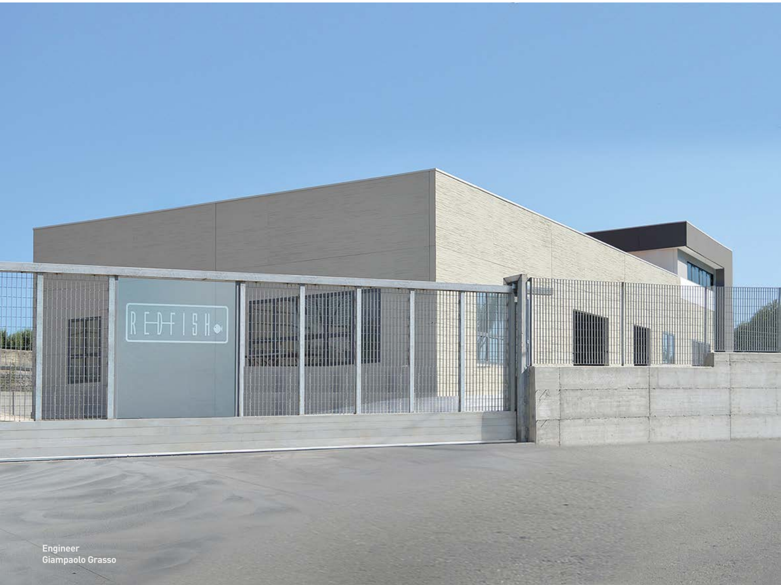
Veduta del fronte di ingresso lato /Sud Ovest
