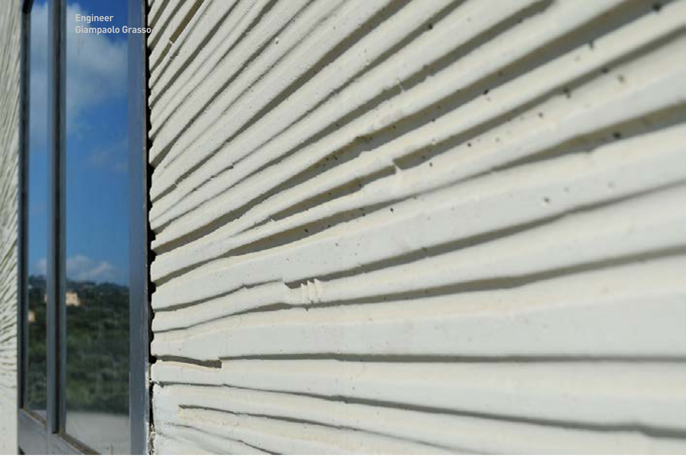
Particolare della matrice di rivestimento del fronte lato /Sud
