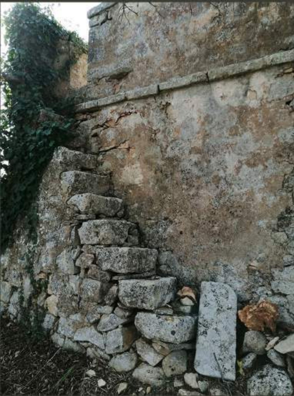
Scala laterale per accesso piano superiore
