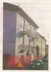
Bolzano, che sta per rilasciare la certificazione ambientale all'intervento roerino, comporta una progettazione accurata dei particolari, ma occorre anche una realizzazione puntuale, senza possibilità di approssimazione. Il nuovo edificio, composto da quattro unità abitative e da una a uso ufficio, è stato realizzato con una struttura tradizionale in cemento armato con tamponamenti in laterizio, il tetto è lasciato a vista con l'ultimo piano soppalcato. «La ricerca di una accura-
