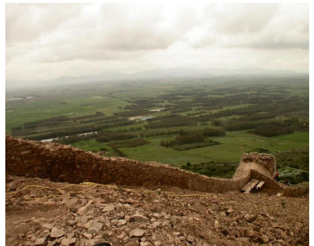
Muratura del borgo tratto B
