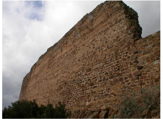
Muratura del Mastio
