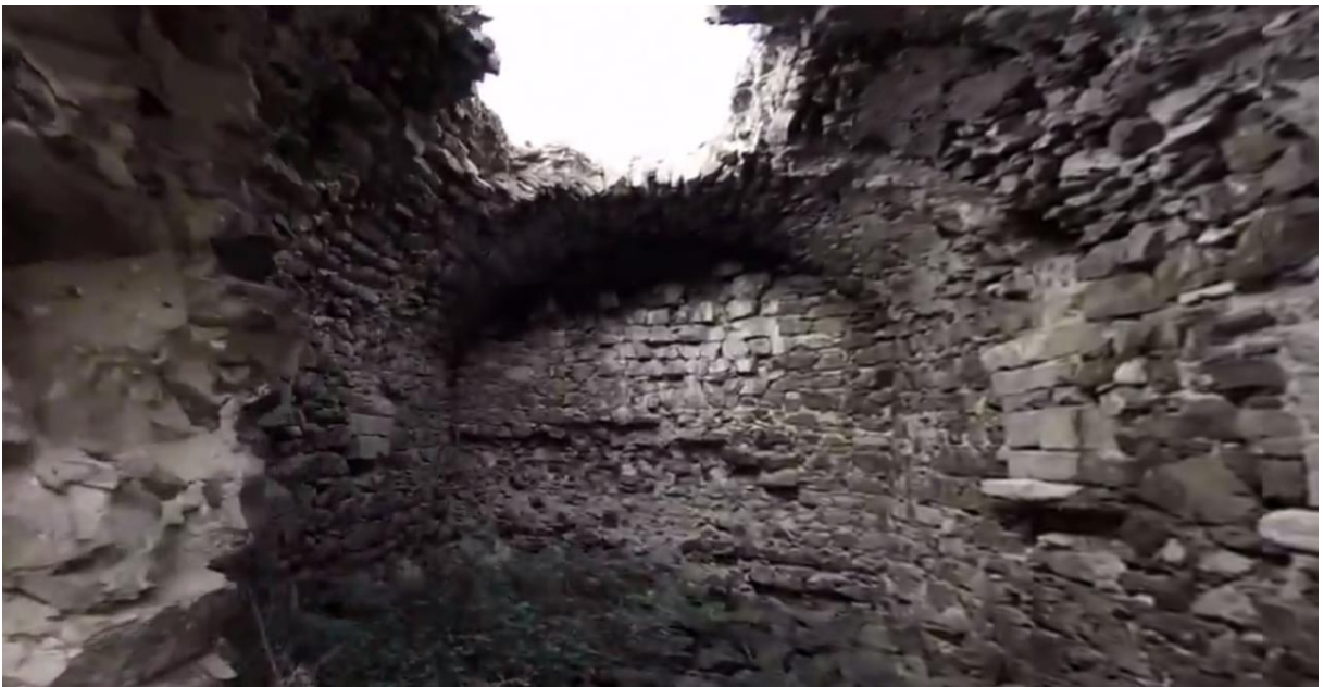
Interno della cisterna
