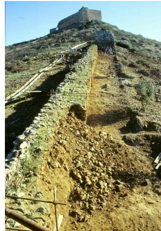
Le mura durante il restauro
