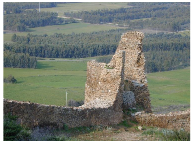
La torre C restaurata
