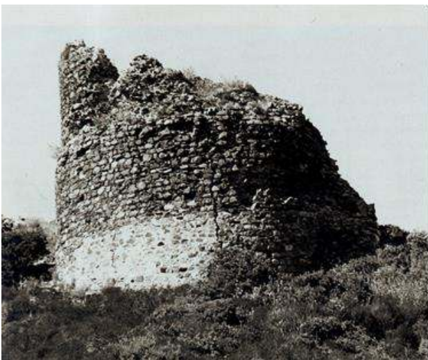
La Torre C - prima del restauro
