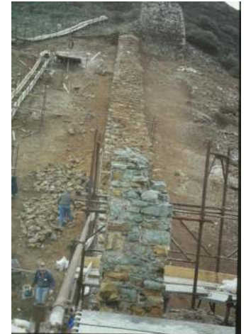
Le mura durante il restauro
