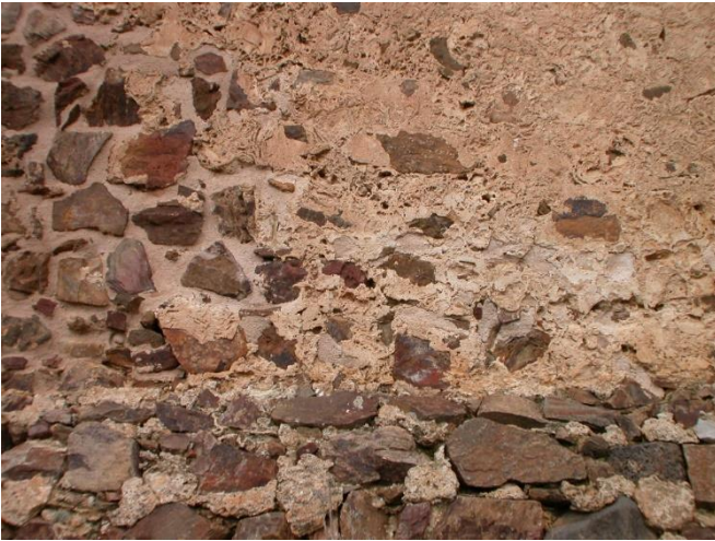
Muratura ed intonaco del Mastio
