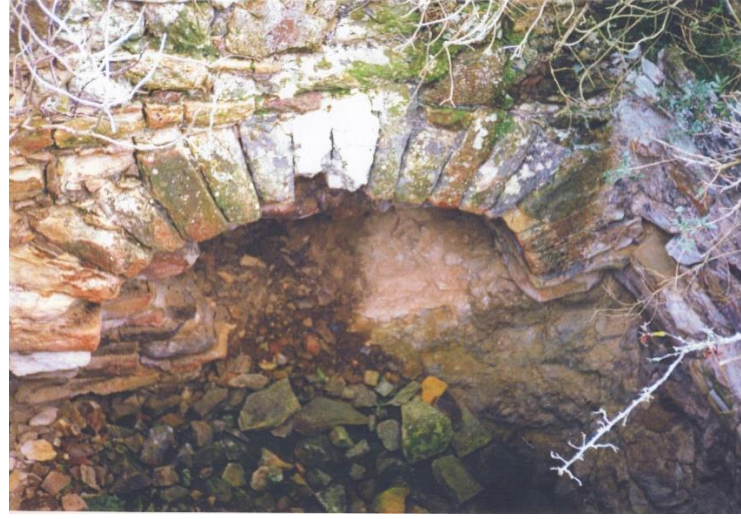
Arco nel compluvio
