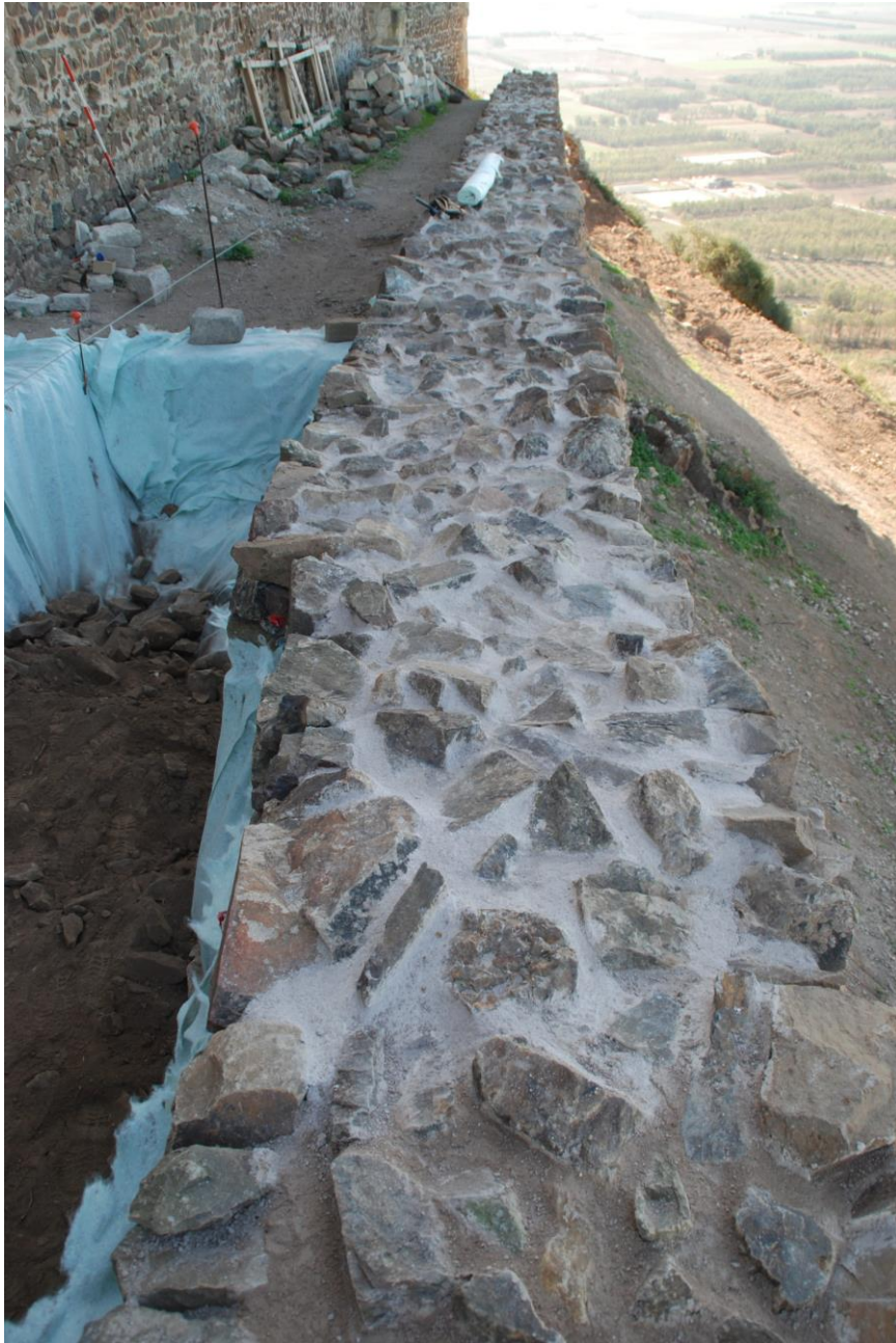
Protezione delle teste dei muri
