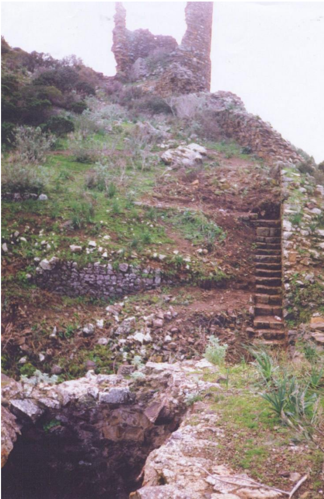
Scala sul percorso di ronda
