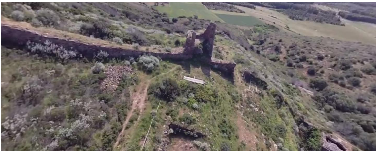
Mura lato San Gavino ad Ovest
