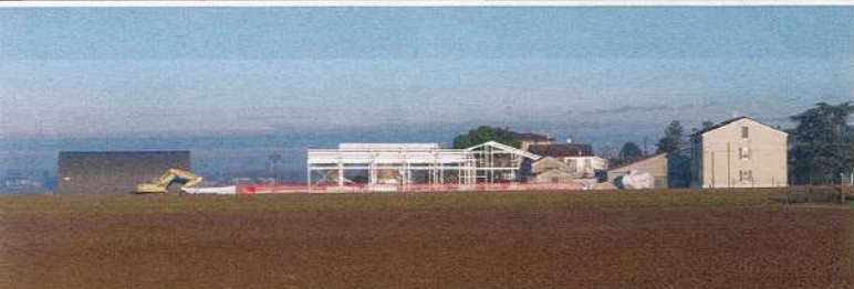
Skyline dell'insediamento produttivo durante le fasi di montaggio delle strutture metalliche
