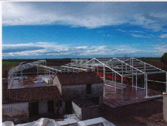
Ossatura metallica della nuova galleria agricola a cielo aperto baricentrica all'insediamento produttivo, con i profili trasversali di collegamento dei due corpi gemelli segnati in asse da un doppio tondo a supporto di piante rampicanti
