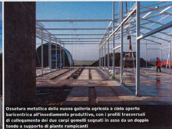
Montaggio delle strutture primarie in carpenteria metallica zincata e verniciata
