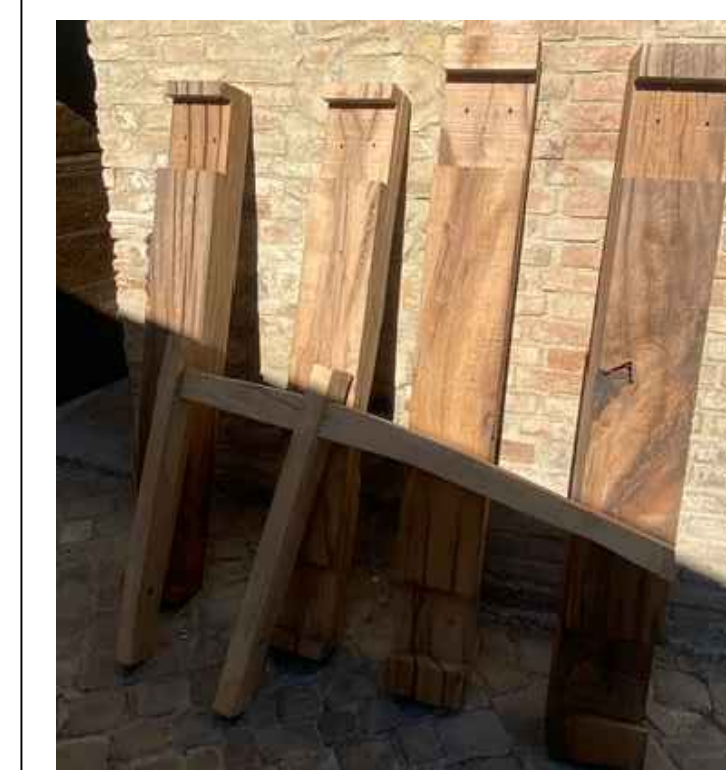
RIPRISTINO IN LEGNO DI ROVERE DEL CASTELLO DI SOSTEGNO DELLA CAMPANA
