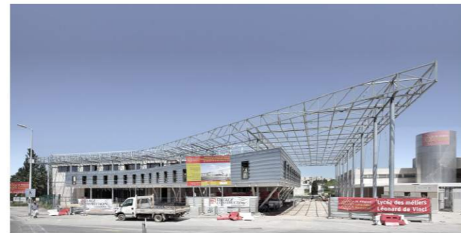
Vue du chantier en mai 2013
