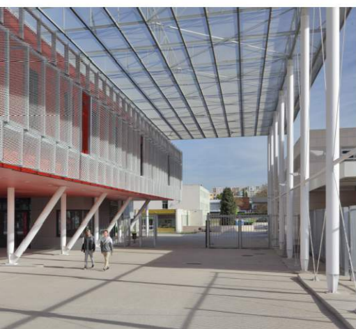
10. L'axe central du lycée, conforté par le portique métallique porteur de l'ombrière
