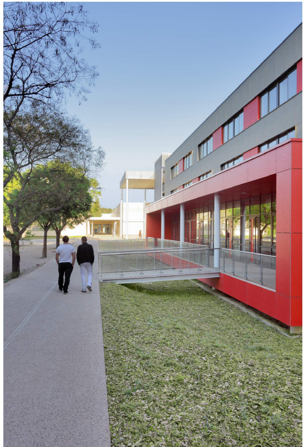
11. Au Nord, la façade sur cour, avec dans un grand cadre rouge, les bureaux de la vie scolaire
