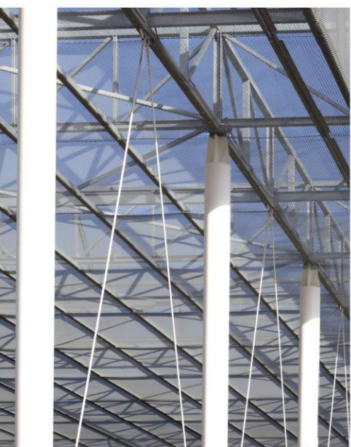
23. Détail de la charpente de l'ombrière
