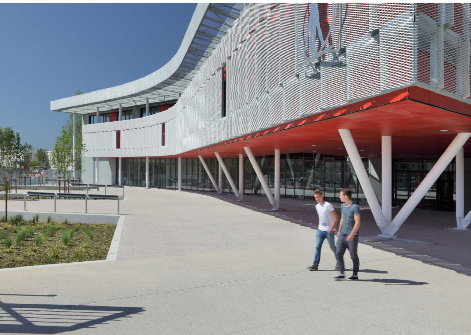
04. Au Sud, la façade d'entrée, protégée de l'ensoleillement par une ombrière horizontale et une résille verticale en façade
