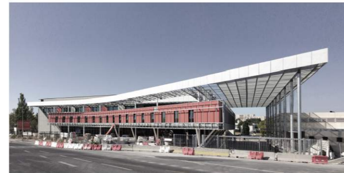
Vue du chantier en septembre 2013
