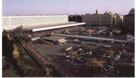
Piazzale di stazione
