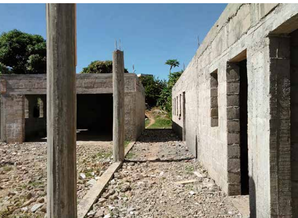
Ultimazione opere in levazione, setti e colonne in c.a. Sopra, realizzazione delle travi reticolari con assi di legno di mangrovia
