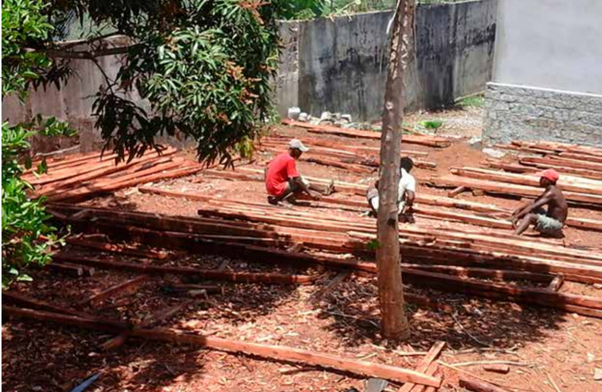
Ultimazione opere in levazione, setti e colonne in c.a. Sopra, realizzazione delle travi reticolari con assi di legno di mangrovia
