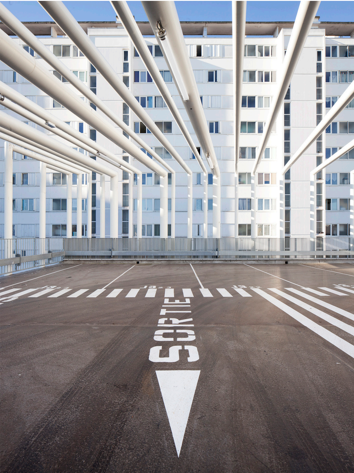
08 - L'envolpe ventilée du parking estompe la limite entre l'espace public et le cœur du bâtiment photo ©Edouard Decam
