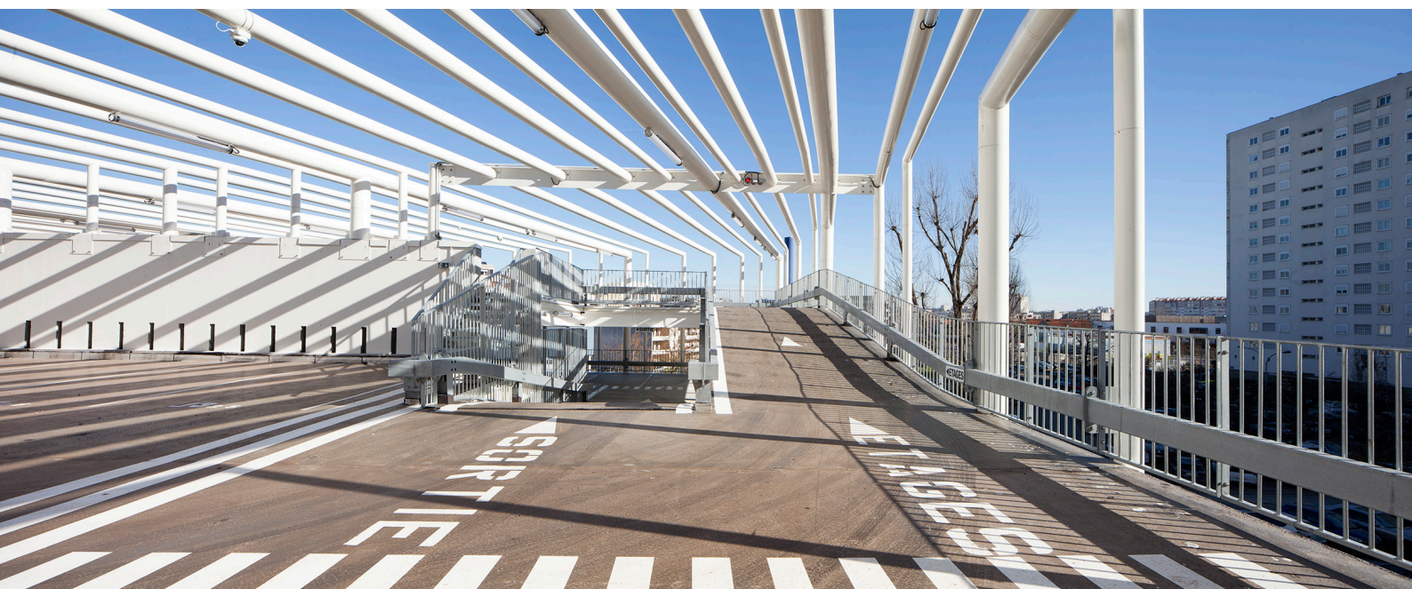
07 - En toiture, la pergola joue avec les ombres et compose une cinquième façade graphique photo ©Edouard Decam
