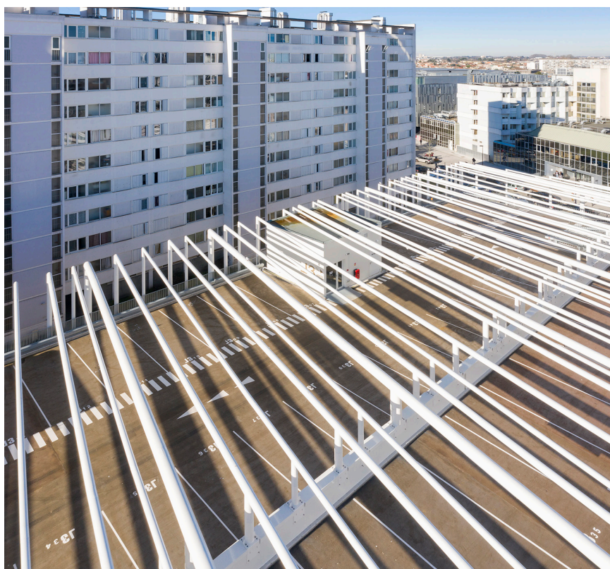
10 - Vue des appartements alentours, sur la toiture évanescente photo ©Edouard Decam
