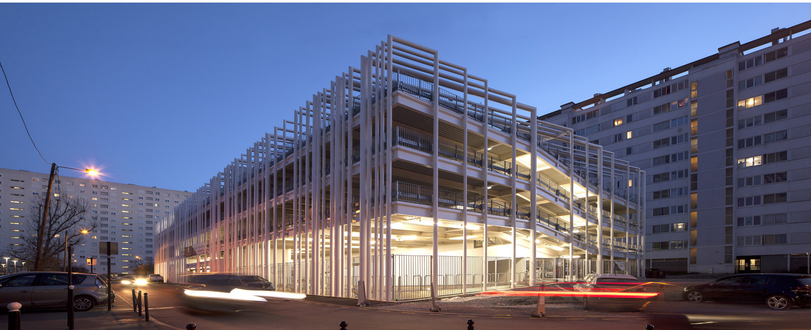
03 - Le parking compose entre filtre et perméabilité, créant un événement dans le quartier photo ©Edouard Decam
