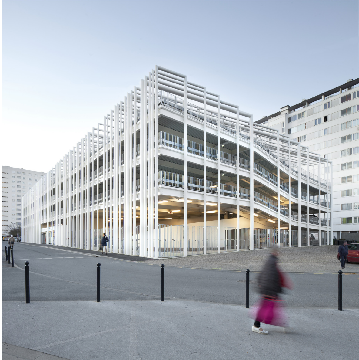
04 - La structure s'élance du rez-de-chaussée au dernier niveau pour se retourner en toiture photo ©Edouard Decam
