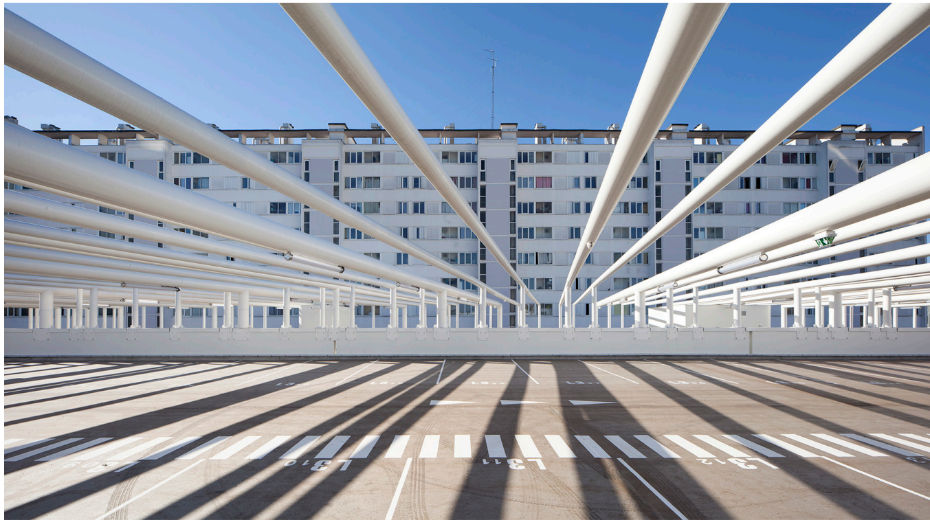
02 - La structure se retourne en toiture pour former une ombrière sur le dernier niveau de véhicule photo ©Edouard Decam
