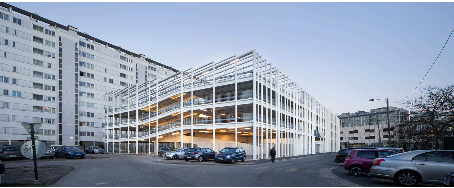
01 - Une structure métallique blanche enveloppe le bâtiment, en façade et en toiture photo ©Edouard Decam
