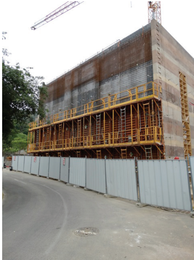
Coulage des voiles en béton
