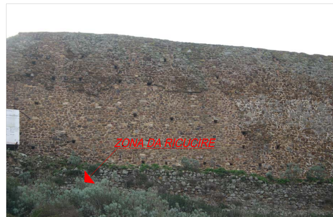
L5 - MURO PERIMETRALE DELLA CINTA DIFENSIVA PROSPICIENTE LA PORTA DI ACCESSO DEL MASTIO
