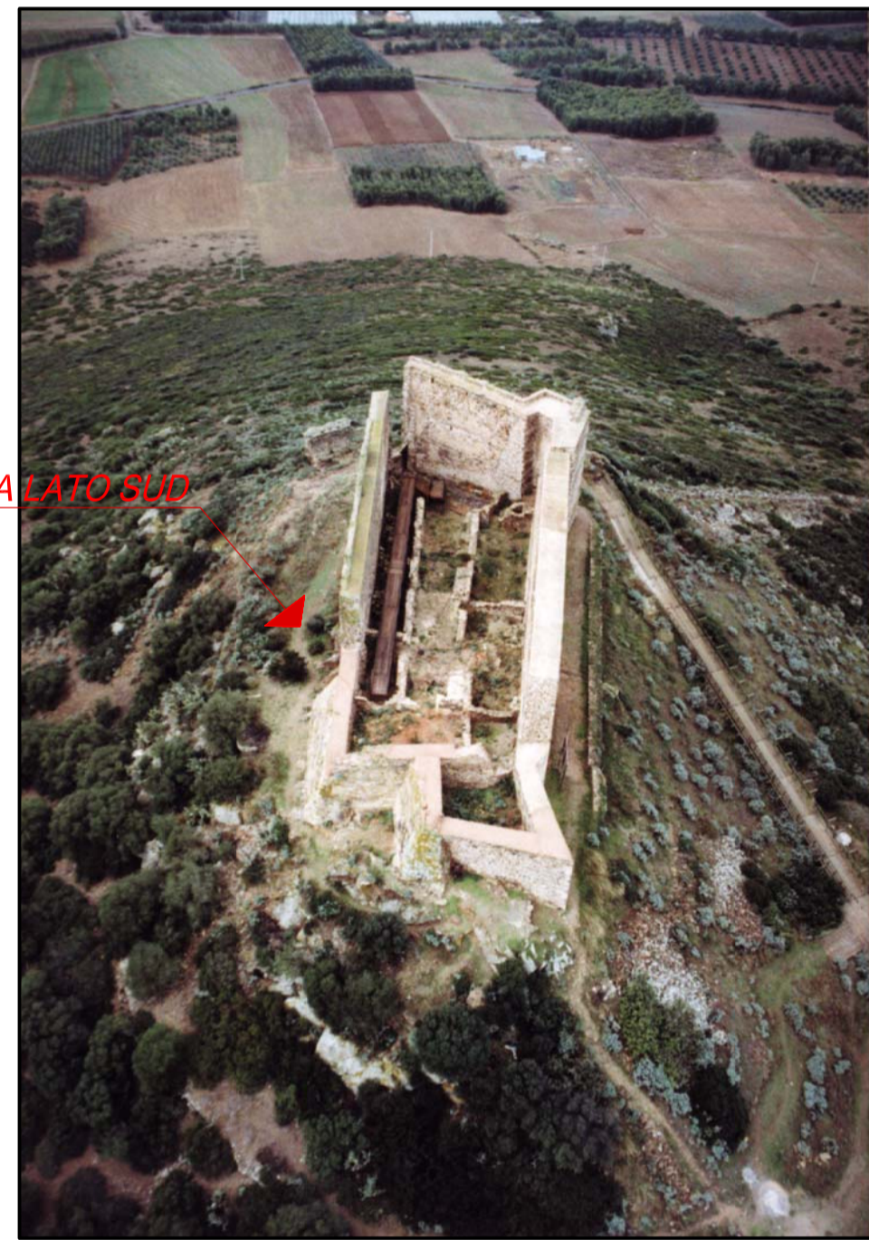
L1 - Restauro della muratura perimetrale attorno al Mastio
