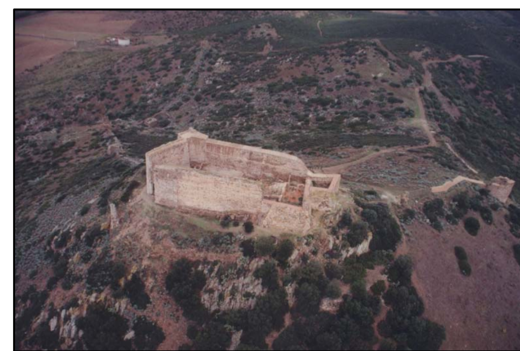
L1 - Restauro della muratura perimetrale attorno al Mastio
