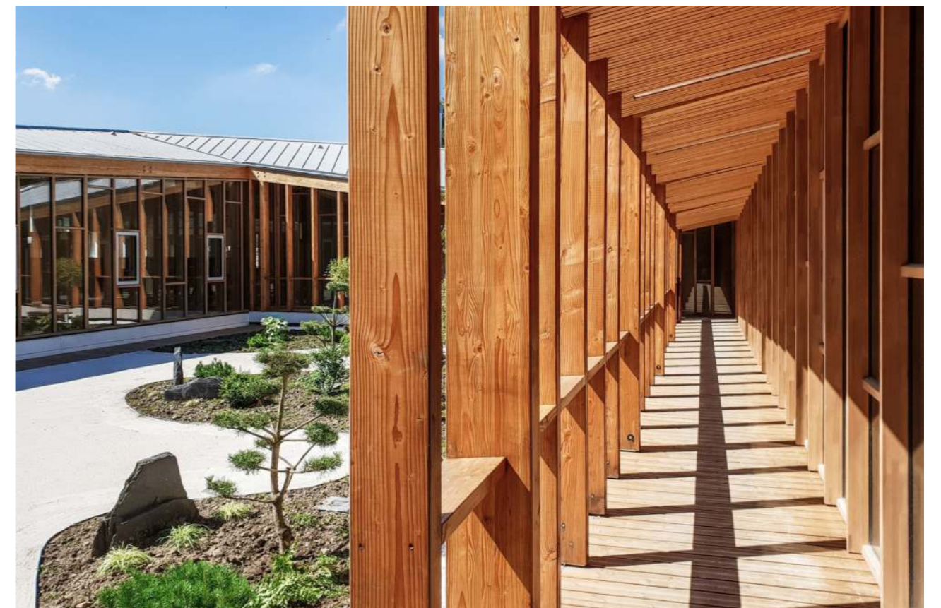
Une intimité intime et chaleureuse avec l'expression du végétal et d'éléments architecturaux en bois (charpente, bardage, plafond et murs rideaux).
