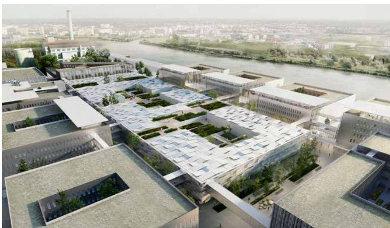
Le nouvel hôpital – Aperçu des toits du plateau technique
