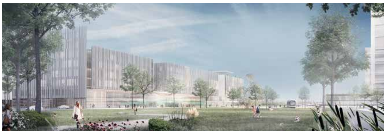
Le nouvel hôpital – Vue depuis le parkway
