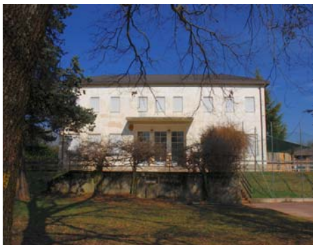
Foto n. 11 . Il fabbricato eretto negli anni '60 del secolo scorso, ha una grande e semplice facciata orientata a Sud.....
