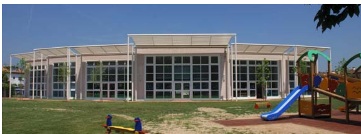
Foto n. 8 In estate le vetrate a Sud sono schermate dai frangisole fissi esterni.
