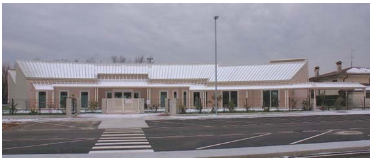
Foto n. 9 In inverno, un porticato lungo il lato Nord, protegge la parete dagli effetti dei venti dominanti, della pioggia battente e della neve.
