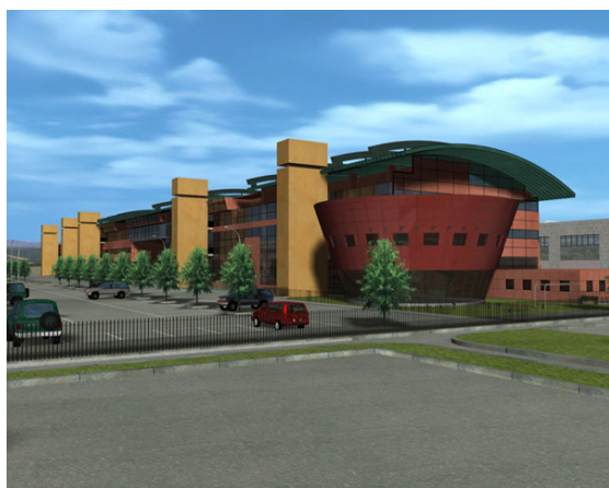
Riqualificazione dell'ex stabilimento Autobianchi di Desio
