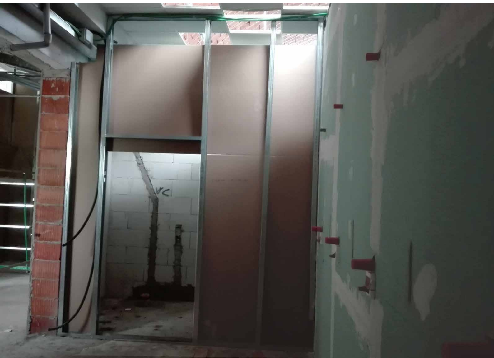
Costruzione delle nuove pareti con lastre GYPSOTECH®
