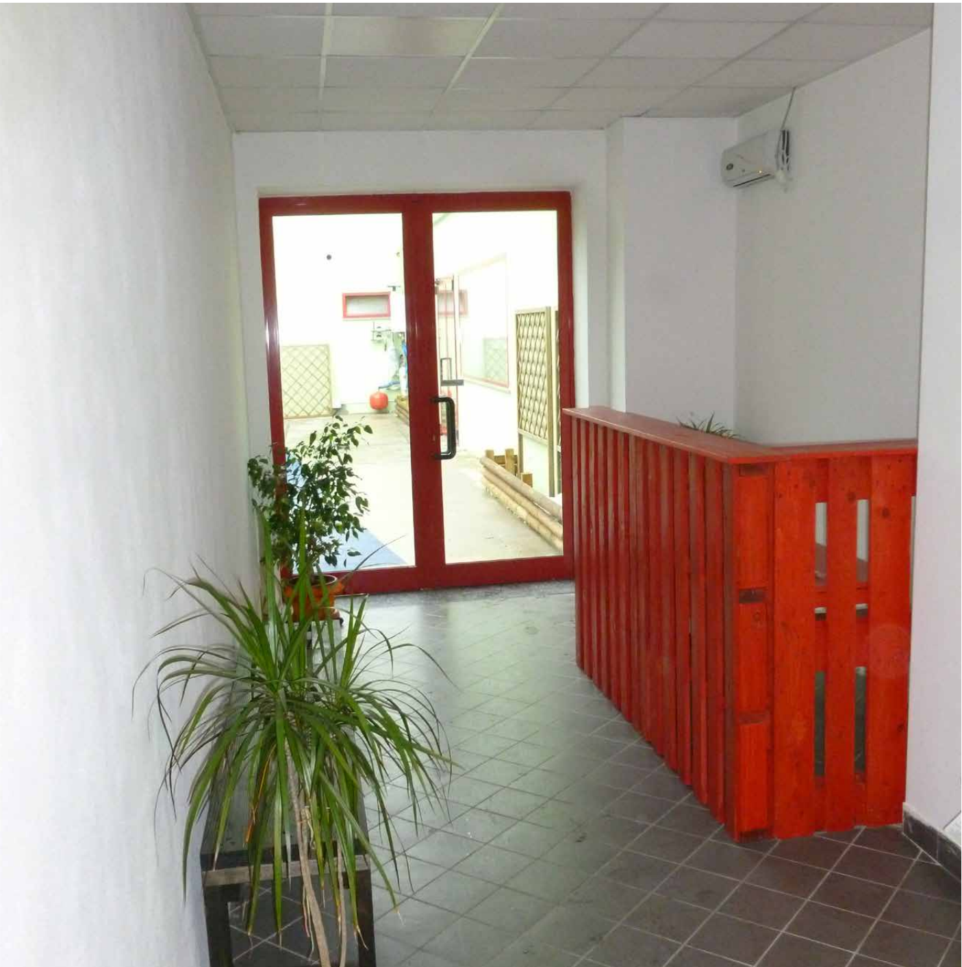
Le pareti di un corridoio costruite con lastre di cartongesso GYPSOTECH®
