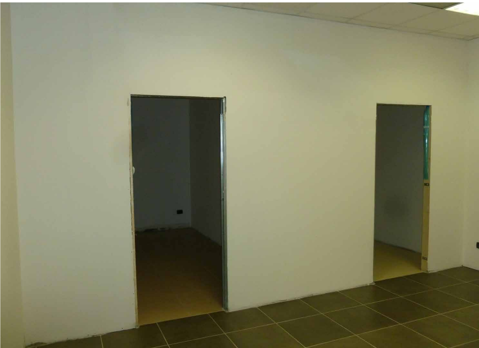
Costruzione delle nuove pareti con lastre GYPSOTECH®
