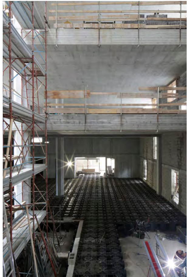
L'interno dell'edificio in costruzione (© Stefano Graziani)
