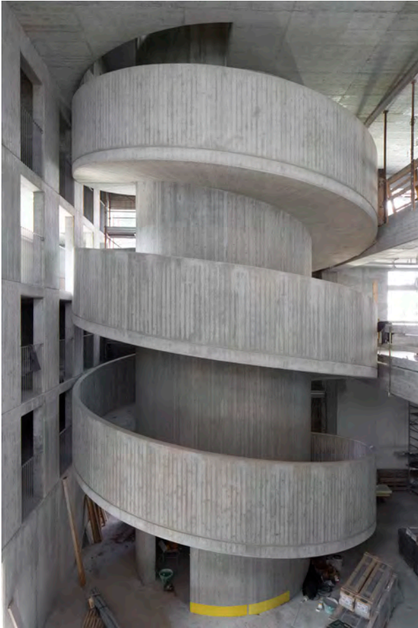
La scala in costruzione tra la parete dell'archivio e gli uffici (© Stefano Graziani)
